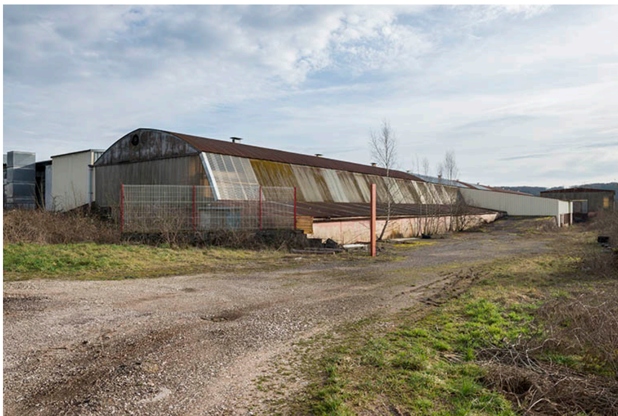
L'atelier de fabrication des panneaux.
