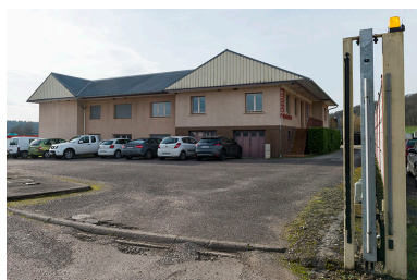
Les bureaux, vue de trois-quarts. Phot. Jérôme Mongreville IVR43_20187000021NUC4A
