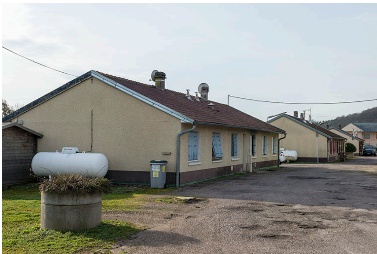
Bâtiment servant de cantine et logement.
