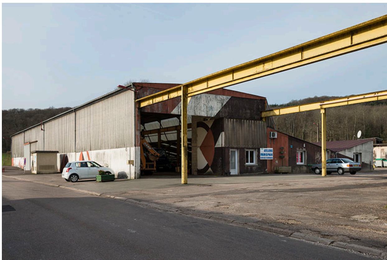
Le bâtiment d'entretien des véhicules.
