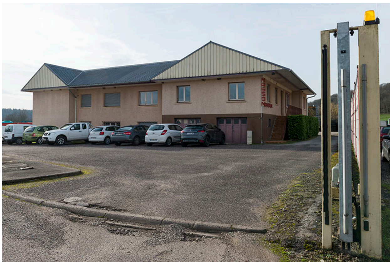
Les bureaux, vue de trois-quarts.
