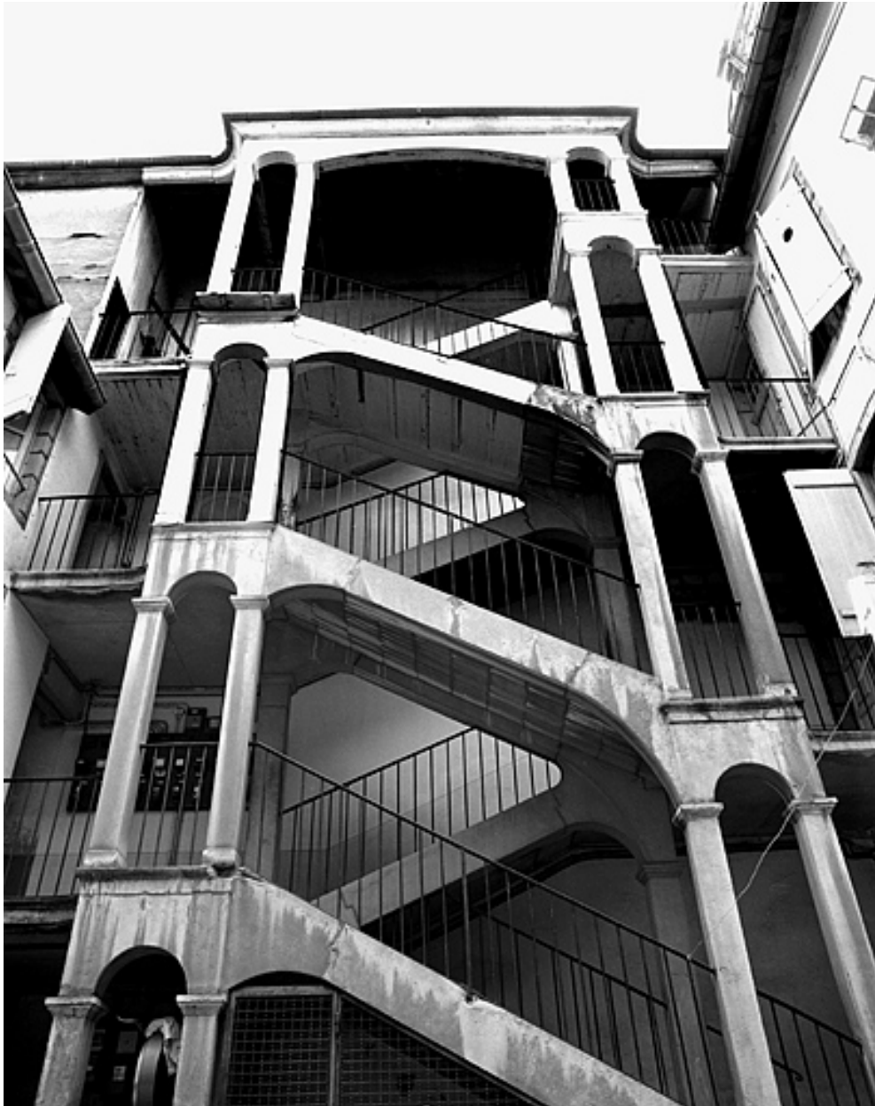
Escalier dans la cour, vue d'ensemble.
