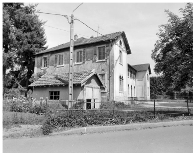
Elévation depuis l'ouest. Phot. Yves Sancey IVR43_200190000480X
