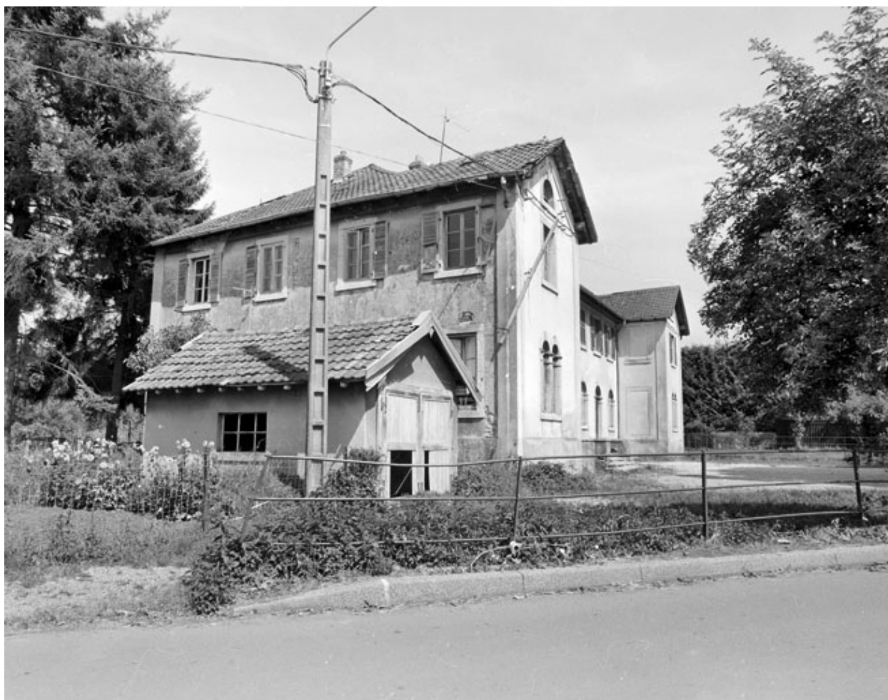
Elévation depuis l'ouest.
