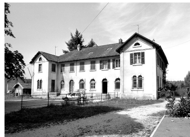
Vue de trois quarts droite. Phot. Yves Sancey IVR43_200190000478X
