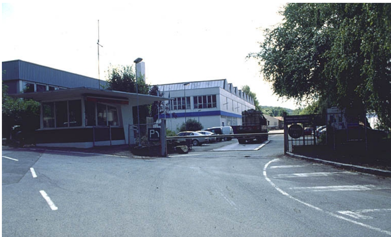
Entrée de l'usine.
