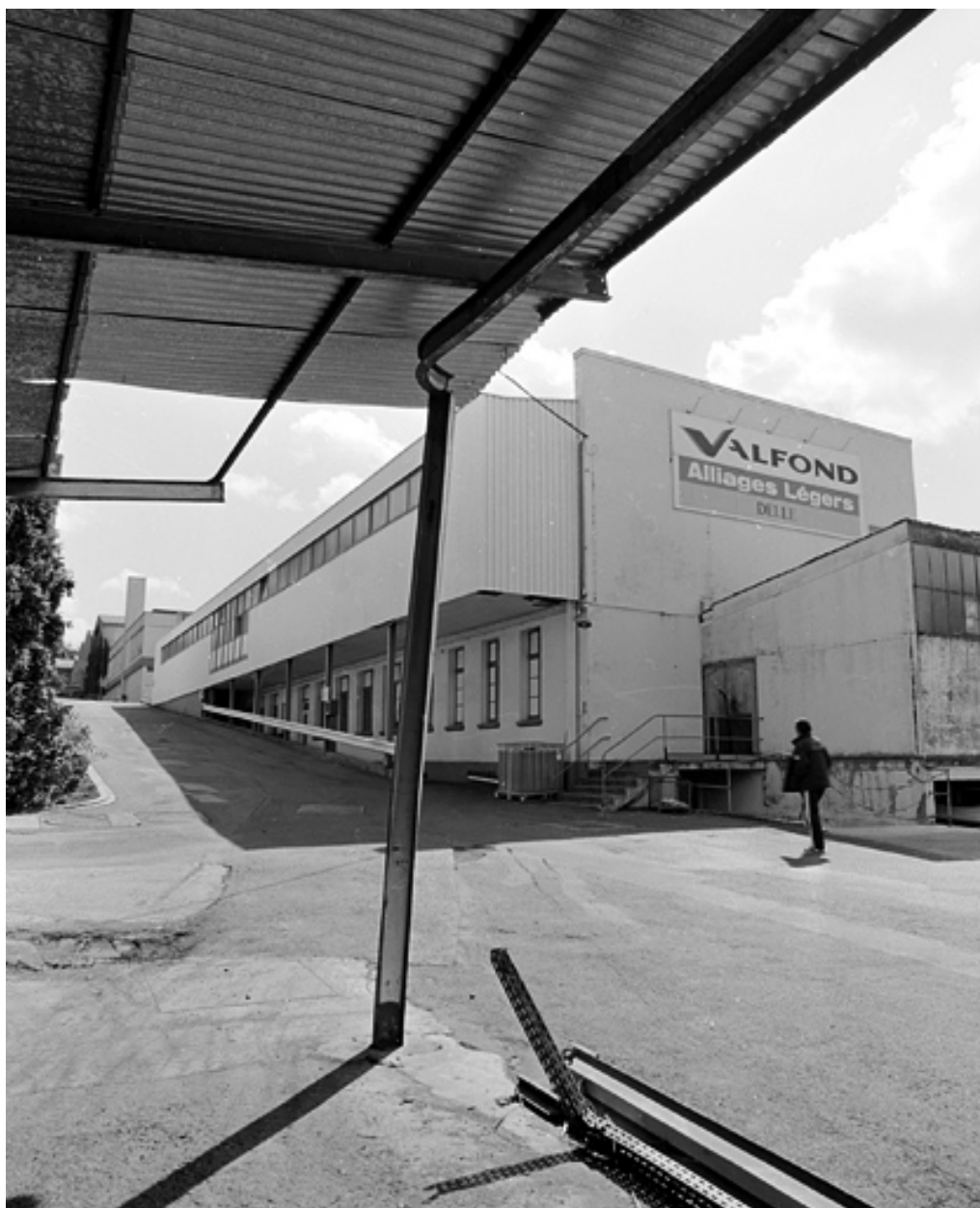
Ateliers de fabrication et vestiaire depuis l'ouest.
