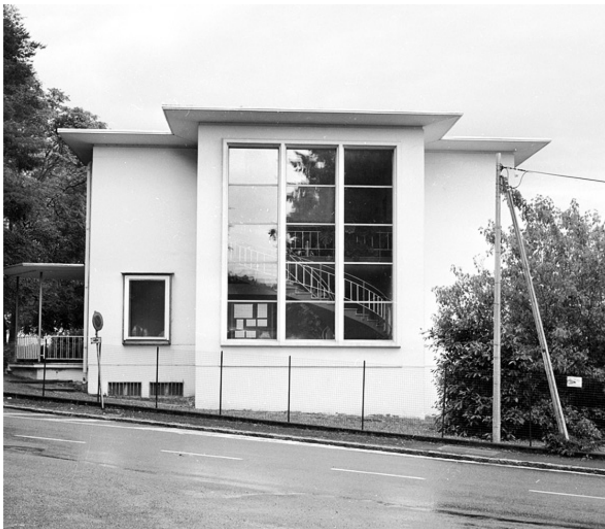
Façade nord du bâtiment administratif d'entreprise.
