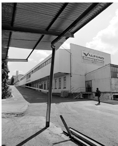
Ateliers de fabrication et vestiaire depuis l'ouest.
