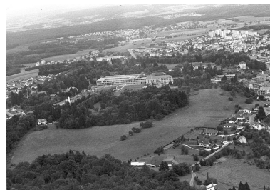
Vue aérienne générale depuis le sud en 1982.
