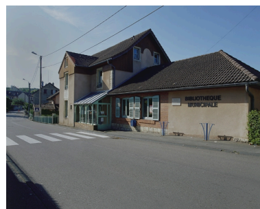
Ecole, dite asile maternel Adolphe Japy fondé en 1871 : vue depuis le nord.
