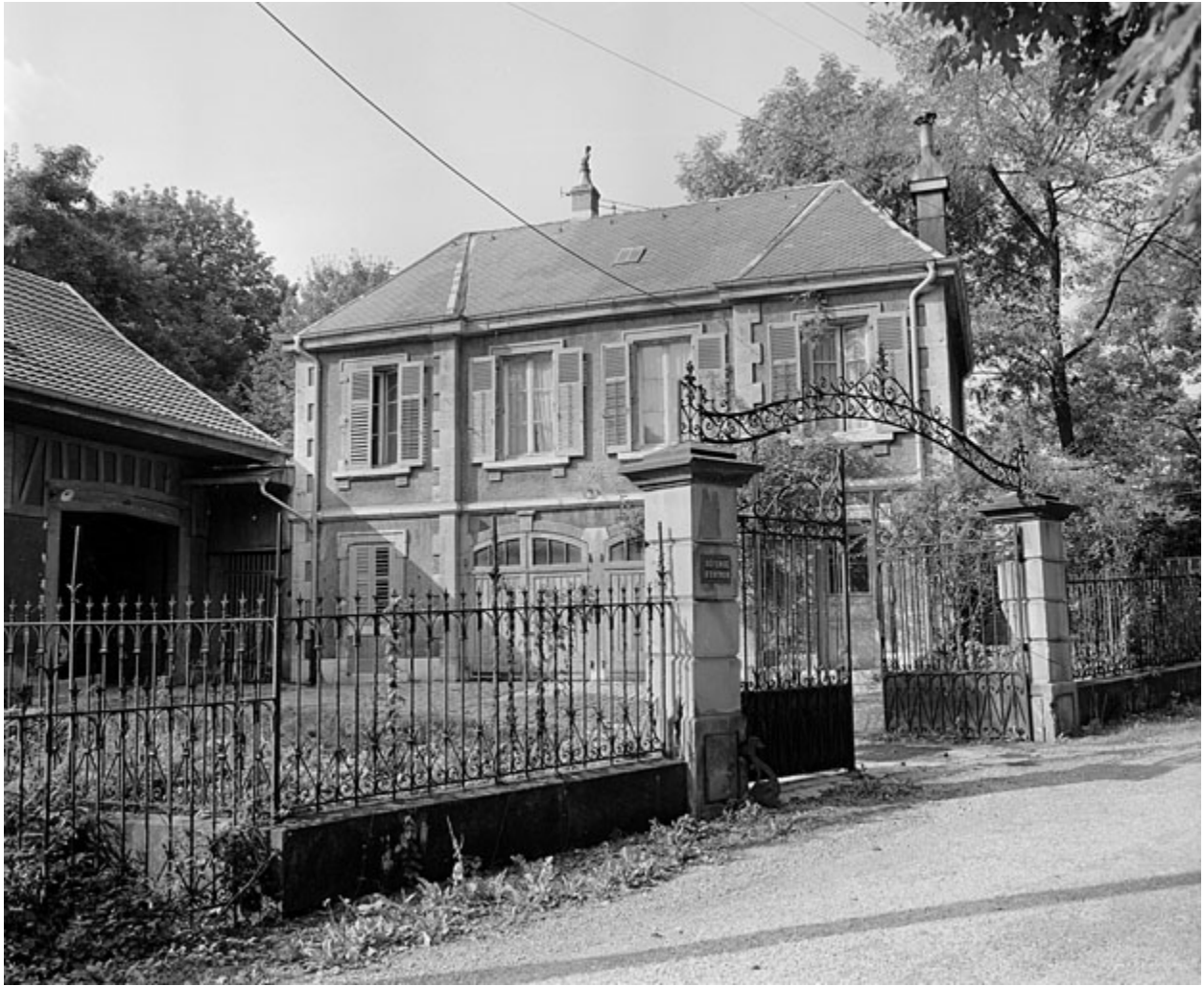
Ecuries et logement du château Bornèque en 1981.SRI. Enquête régionale sur les bâtiments industriels (1979-1981).
