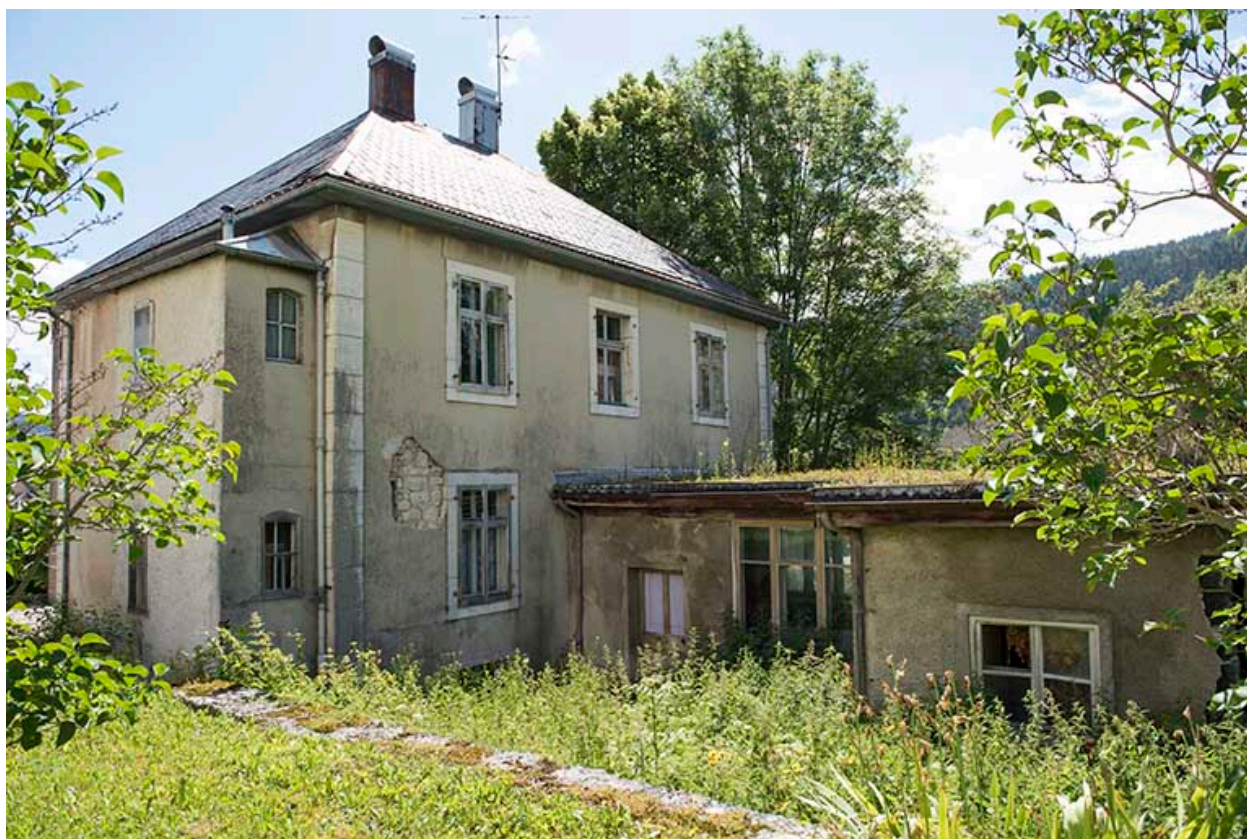
Façade postérieure et atelier de fabrication.
