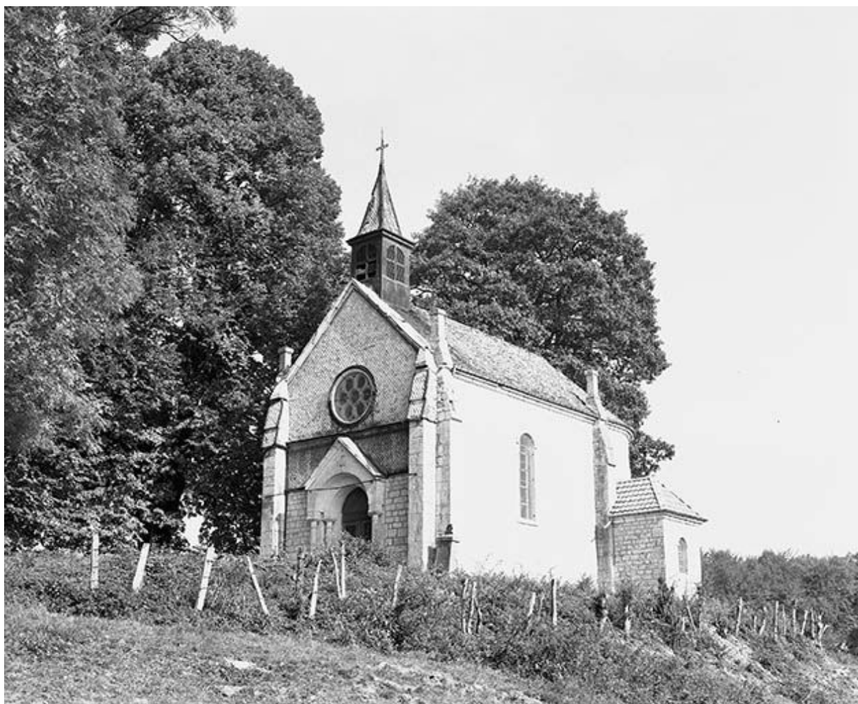
Façade antérieure et face latérale droite.
