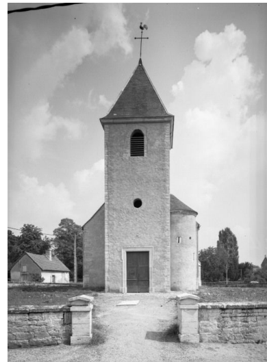
Elévation antérieure Phot. Michel Thierry IVR26_19862101206V
