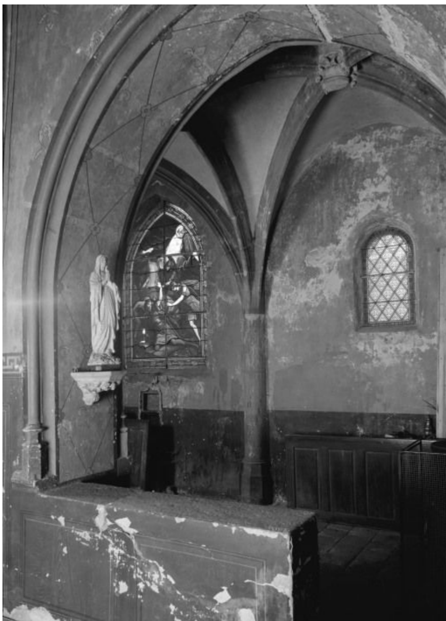
Chapelle latérale, première travée
