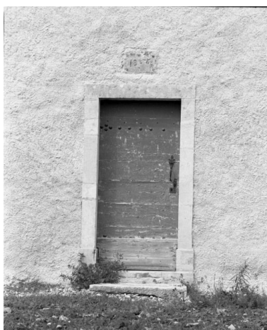
Elévation droite, porte latérale Phot. Michel Thierry IVR26_19862101215X
