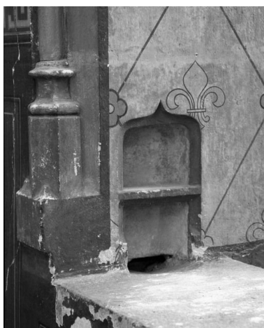
Chapelle latérale : lavabo Phot. Michel Thierry IVR26_19862101229X
