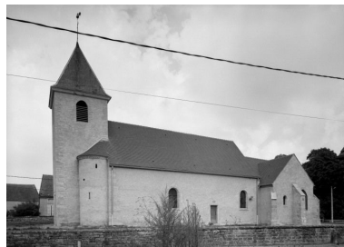
Elévation droite Phot. Michel Thierry IVR26_19862101208V
