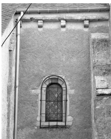
Elévation gauche, fenêtre et corniche du chœur Phot. Michel Thierry IVR26_19862101213X
