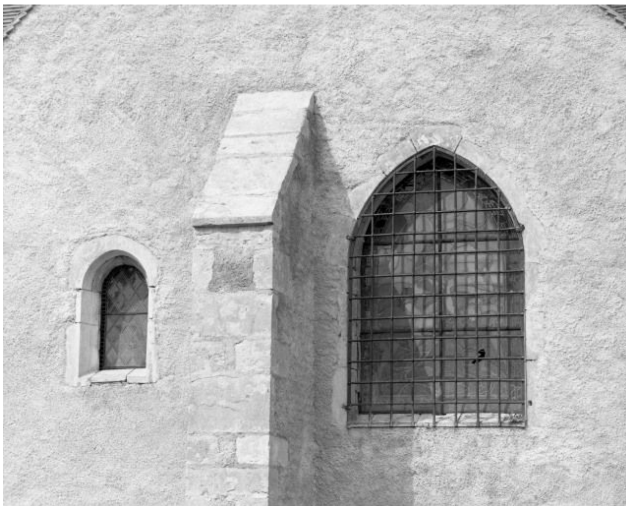
Chapelle latérale droite, baies
