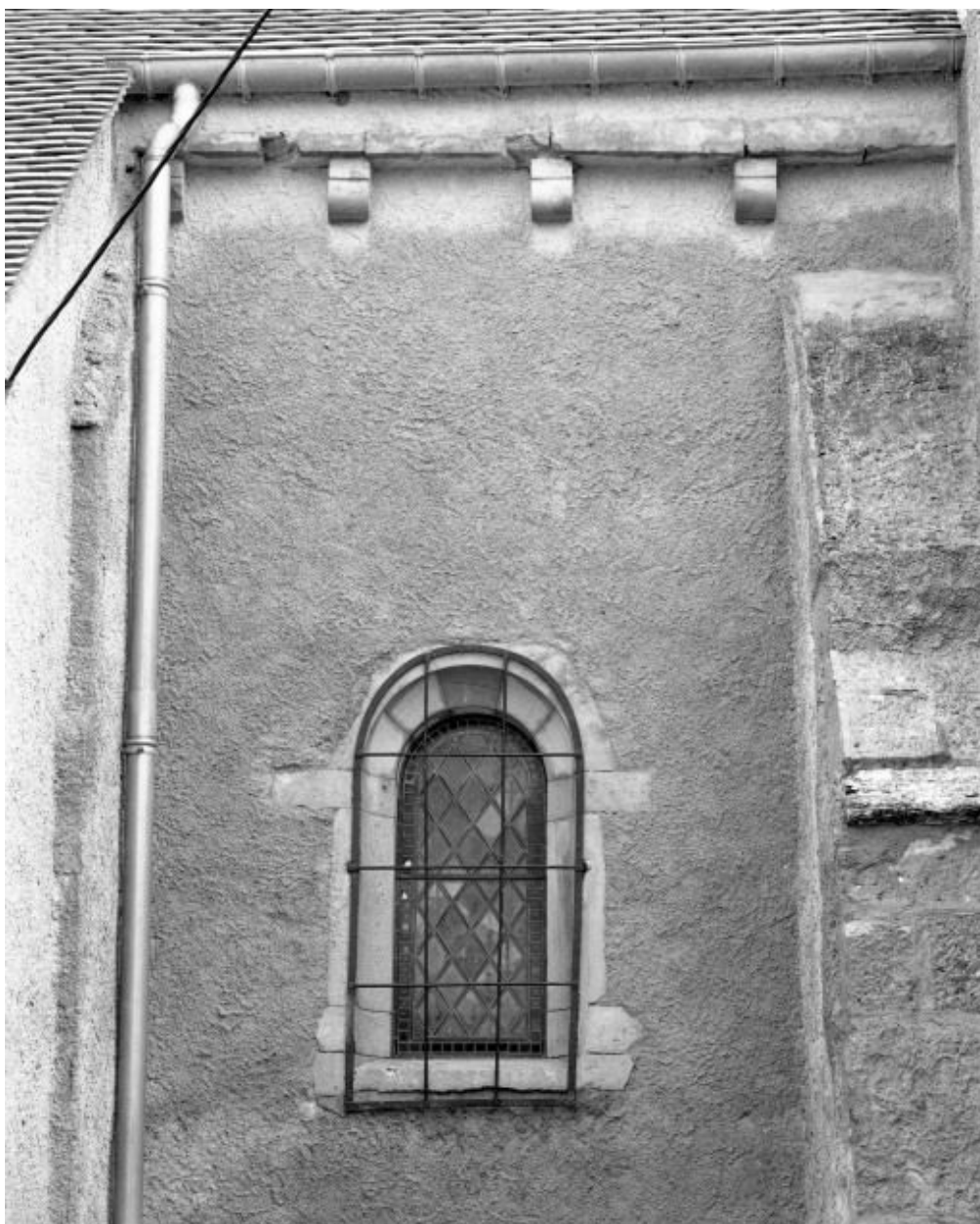
Elévation gauche, fenêtre et corniche du chœur
