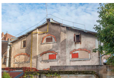
Façade postérieure de la halle (partie haute). Phot. Jérôme Mongreville IVR43_20232500550NUC4A
