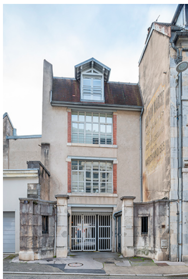
Bâtiment au 5 rue du Palais de Justice.
