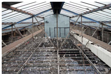
Halle : charpente métallique et verrière.
