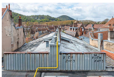
Halle : verrière. Phot. Jérôme Mongreville IVR43_20232500079NUC4A
