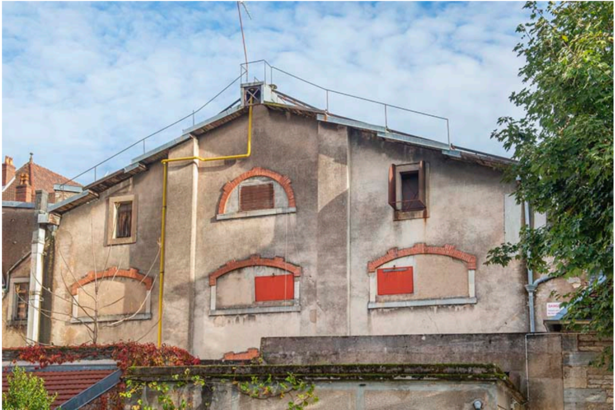
Façade postérieure de la halle (partie haute).
