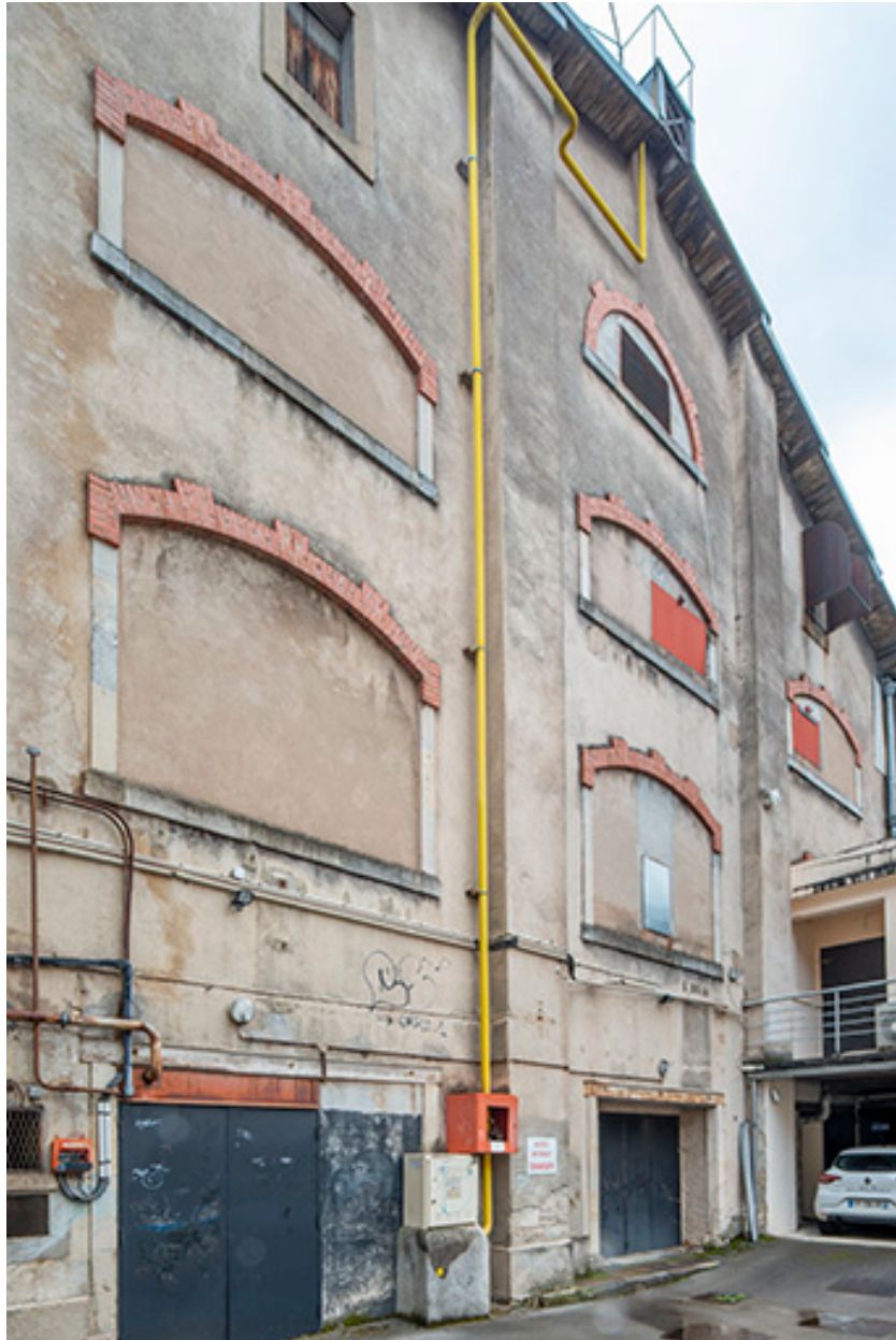
Halle : façade postérieure depuis la cour.
