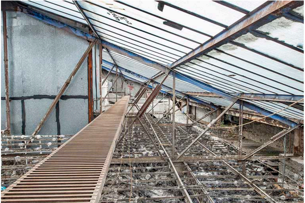
Halle : charpente métallique et passerelle.
