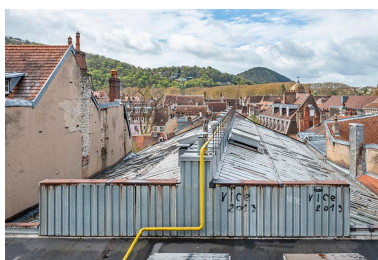
Halle : verrière, de léger trois quarts. Phot. Jérôme Mongreville IVR43_20232500080NUC4A
