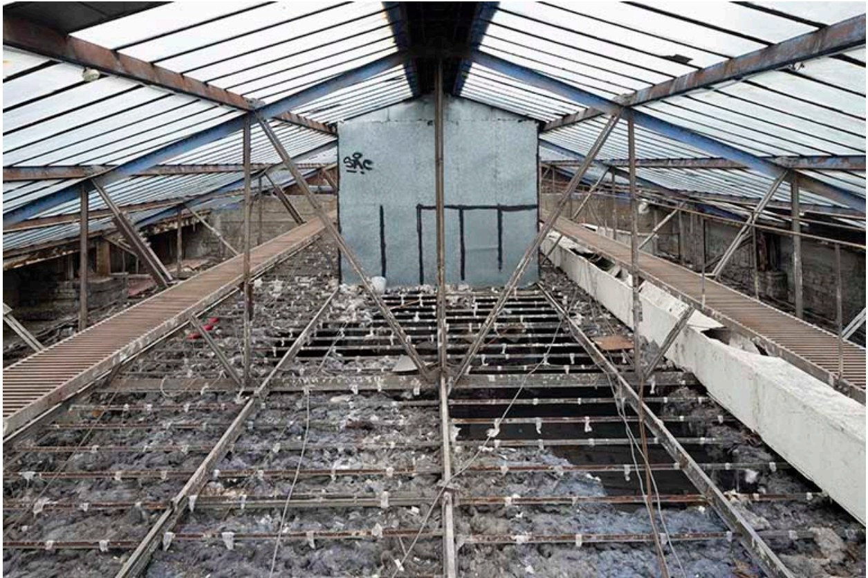
Halle : charpente métallique et verrière.
