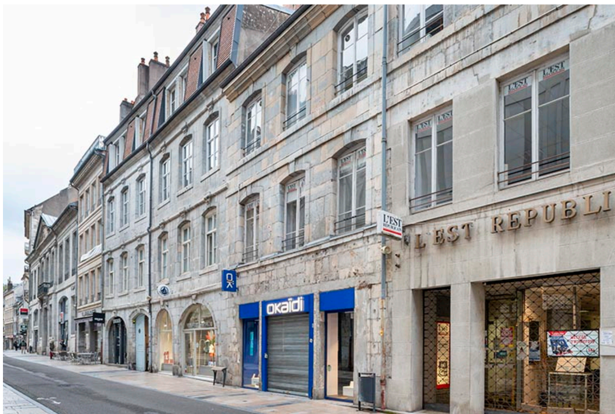
Vue d'ensemble des façades des n° 60 à 64 Grande Rue, de trois quarts droite.
