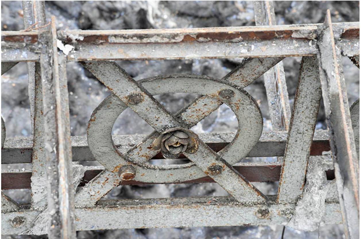
Halle : décor de la charpente métallique.
