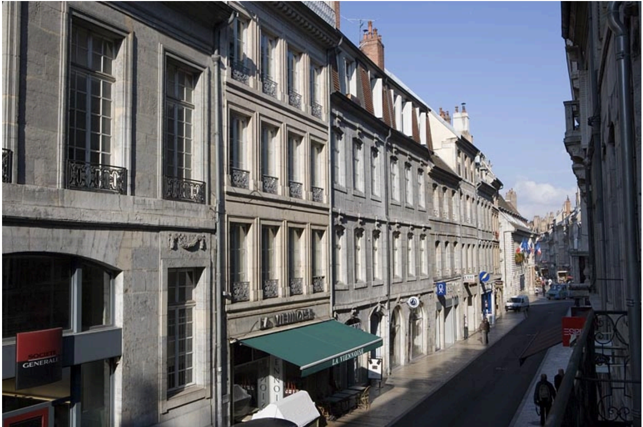
Vue d'ensemble des façades sur la Grande Rue, de trois quarts gauche.
