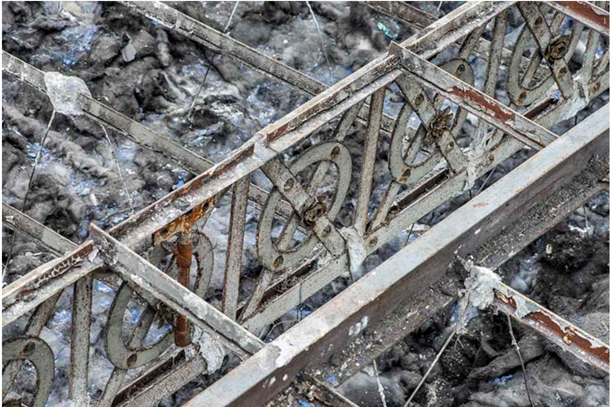
Halle : détail de la charpente métallique.
