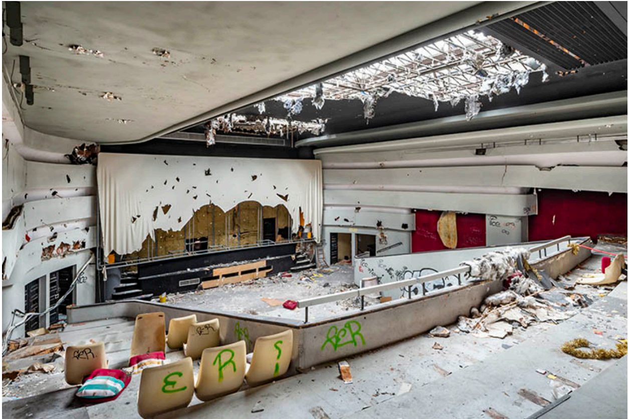
Halle : grande salle, vue depuis le balcon, de trois quarts gauche.
