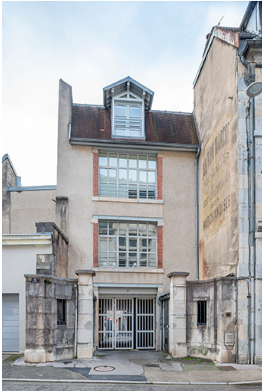
Bâtiment au 5 rue du Palais de Justice.
