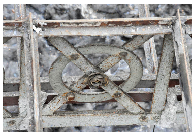
Halle : décor de la charpente métallique.
