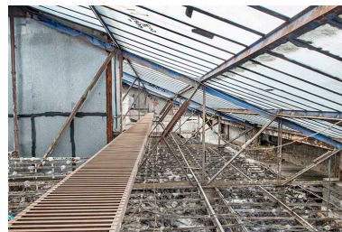
Halle : charpente métallique et passerelle.
