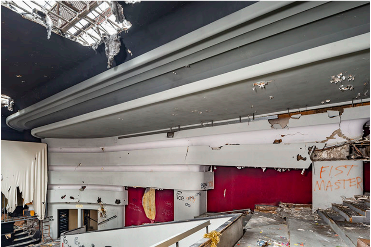
Halle : grande salle, paroi latérale droite et corniches.
