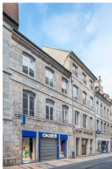
Vue d'ensemble des façades des n° 62 à 58 Grande Rue, de trois quarts gauche. Phot. Jérôme Mongreville IVR43_20232500077NUC4A
