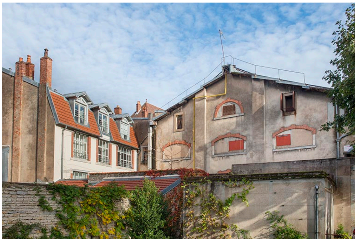
Vue d'ensemble des façades postérieures du bâtiment au 5 rue du Palais de Justice (à gauche) et de la halle (à droite).
