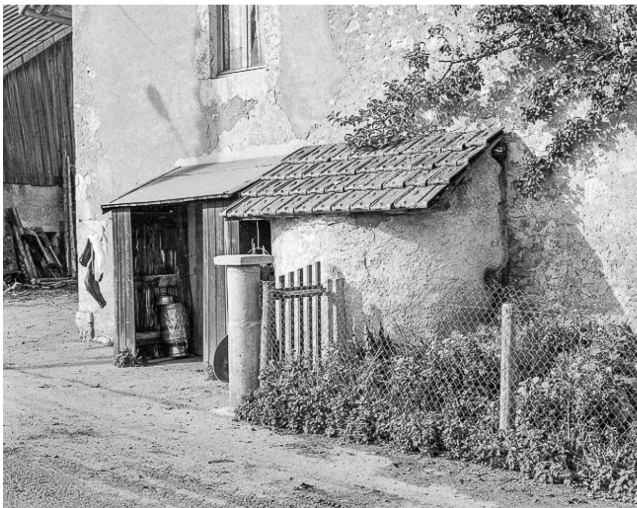
Ferme située à Fourcatier : le cul-de-four.
