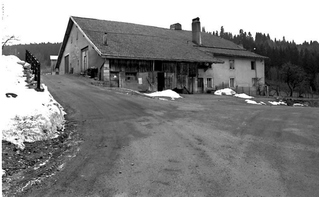
Ferme située à Maison-Neuve
