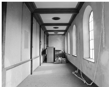
Vue intérieure de la tribune sud.
