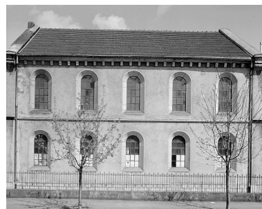
Élévation côté avenue Wilson. Phot. Jérôme Mongreville IVR43_19882500091V
