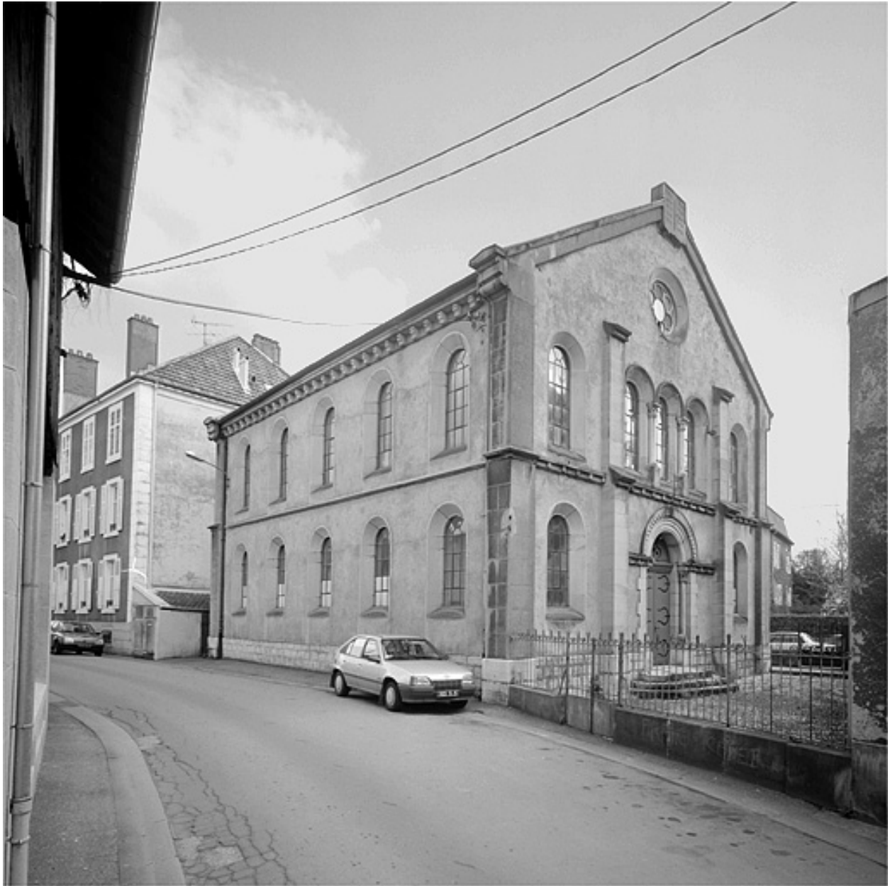
Vue d'ensemble côté rue de la Synagogue.
