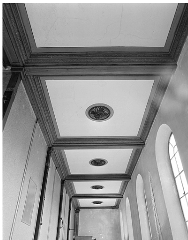
Plafond de la tribune sud.
