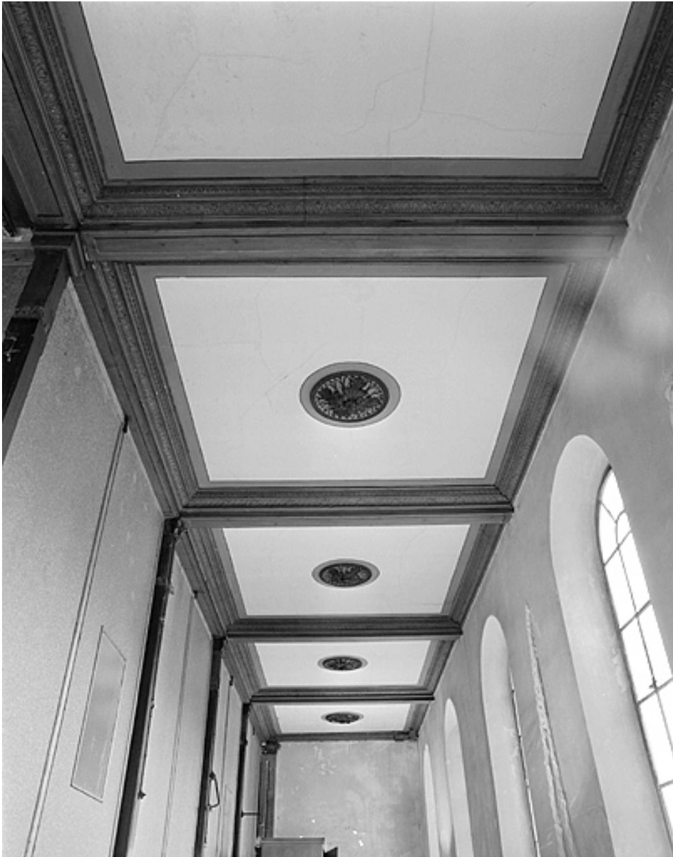
Plafond de la tribune sud.
