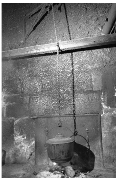
Cheminée de la cuisine.
