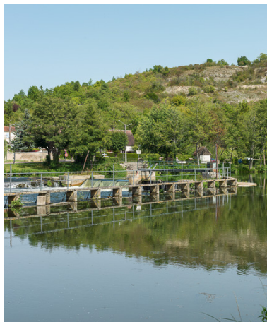
Vue du barrage.
