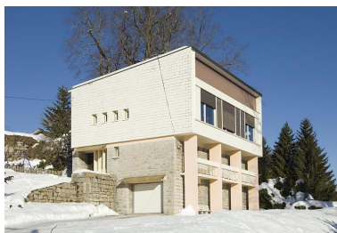
Vue de trois quarts depuis la cour. Phot. Jérôme Mongreville IVR43_20092500031NUC2A
