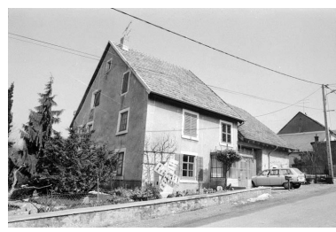
maison de 1892 Phot. Bernard Lardière IVR43_19829000249Z
