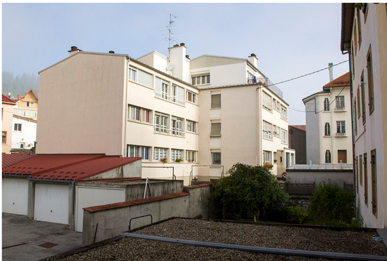
Bâtiment sud : vue d'ensemble, depuis le sud.
