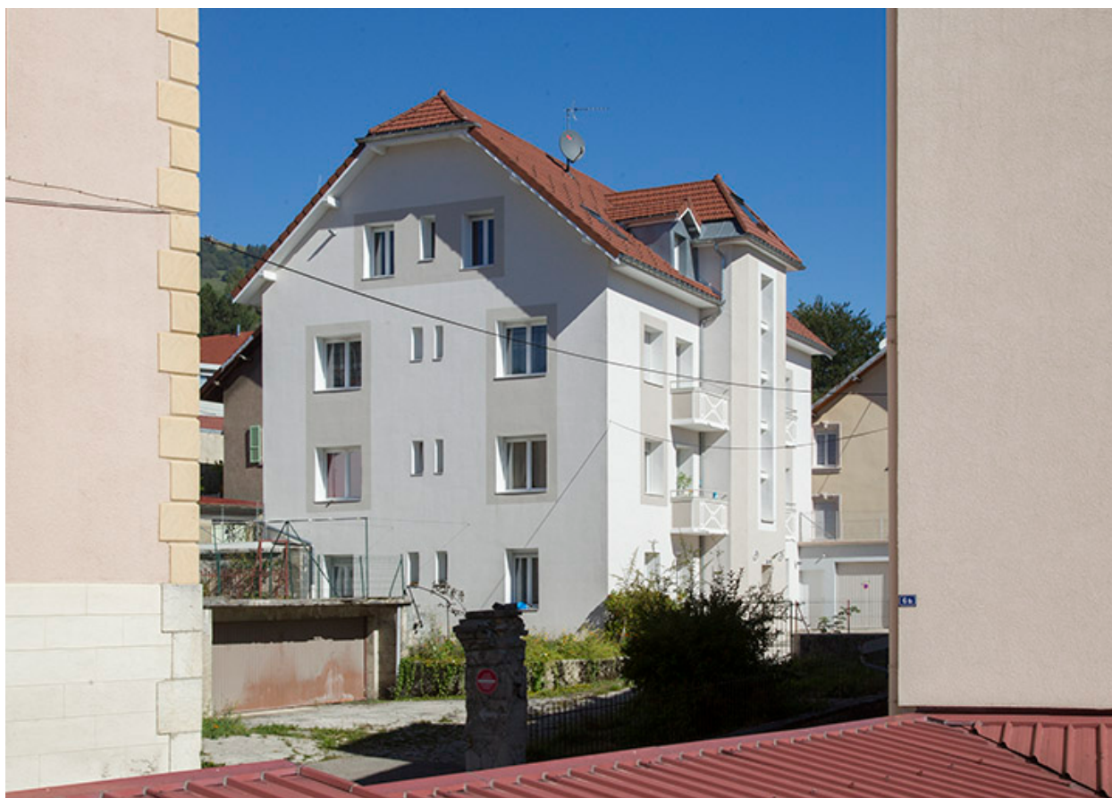
Bâtiment nord : vue d'ensemble, depuis le sud.
