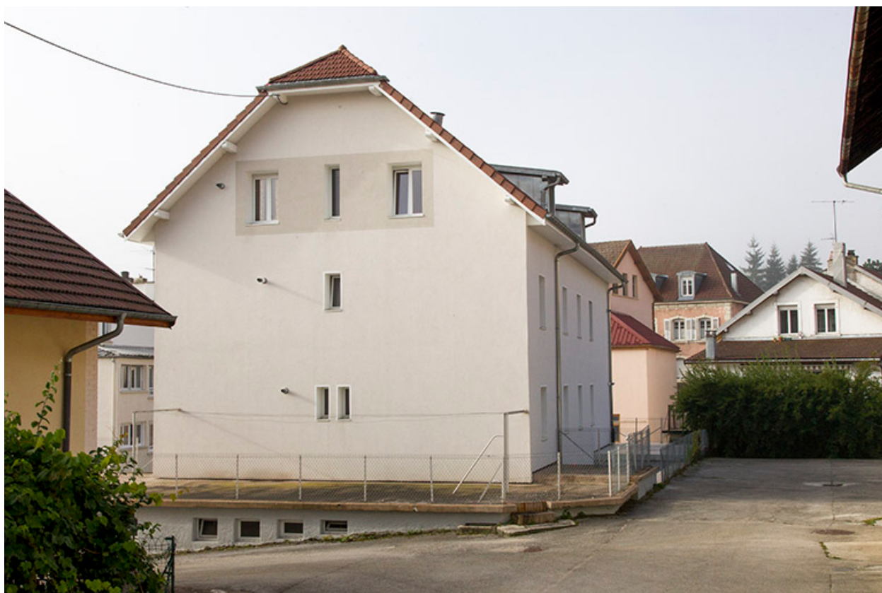
Bâtiment nord : façades latérale droite et postérieure.
