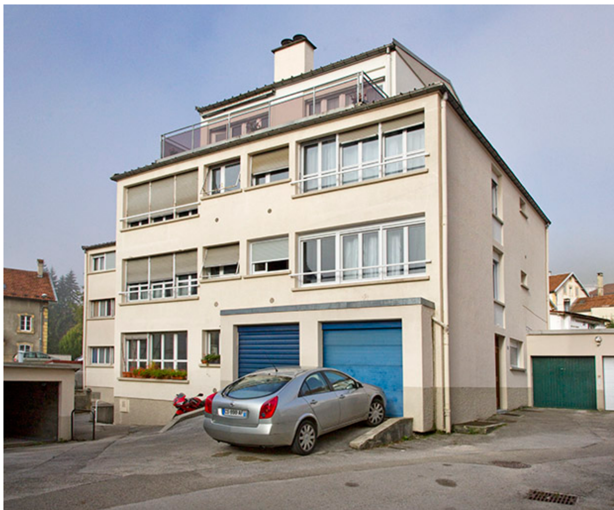
Bâtiment sud : façades antérieure et latérale droite.
