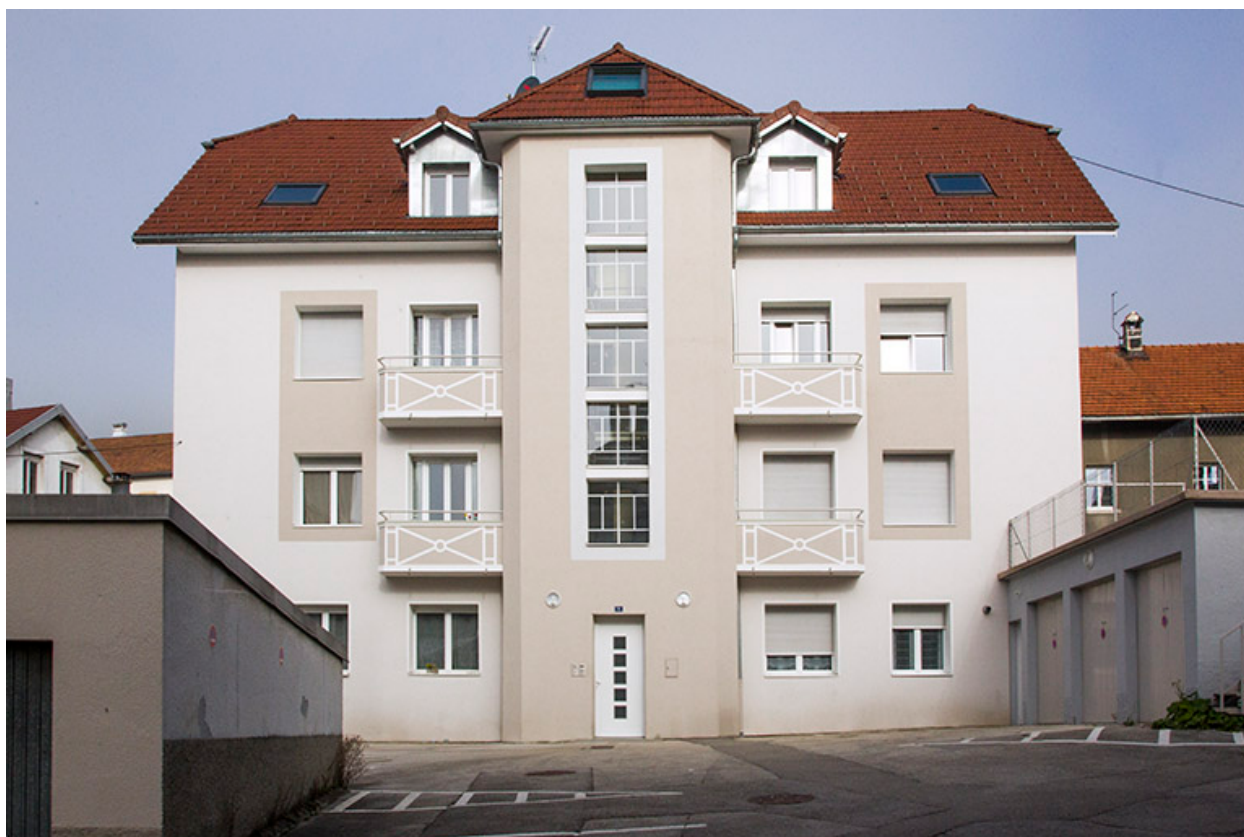
Bâtiment nord : façade antérieure.
