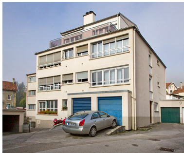
Bâtiment sud : façades antérieure et latérale droite. Phot. Yves Sancey IVR43_20132502281NUC2A
