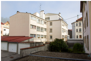
Bâtiment sud : vue d'ensemble, depuis le sud. Phot. Yves Sancey IVR43_20132502285NUC2A
