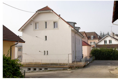
Bâtiment nord : façades latérale droite et postérieure. Phot. Yves Sancey IVR43_20132502284NUC2A
