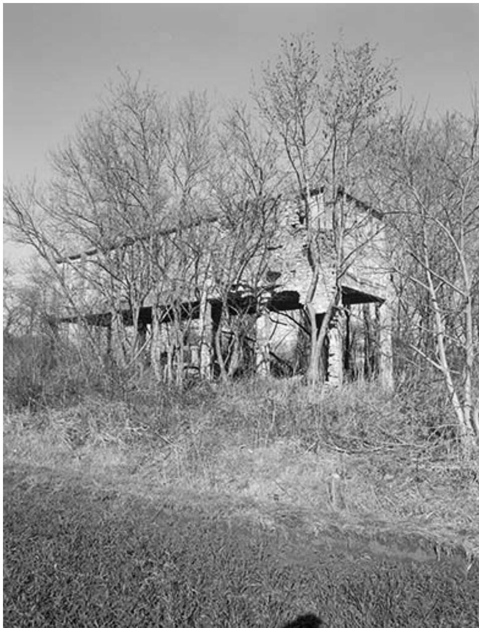
Réservoir industriel (bac à saumure).
