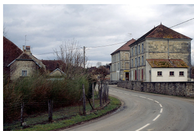
Bureaux et logements depuis la route. Phot. Yves Sancey IVR43_19973900349ZA
