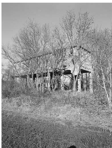
Réservoir industriel (bac à saumure).
