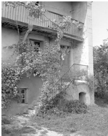
Façade antérieure, accès au logis de droite. Phot. Jérôme Mongreville IVR43_19943901142X
