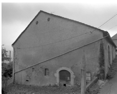
Face droite avec accès à l'étable. Phot. Jérôme Mongreville IVR43_19943901146X
