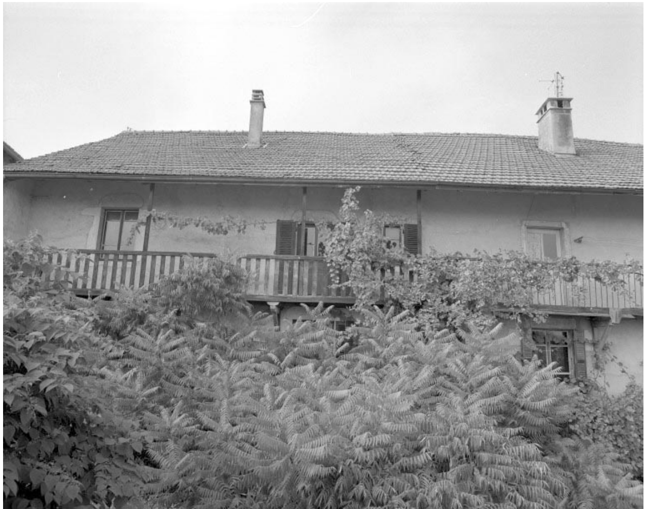
Façade antérieure, balcon.
