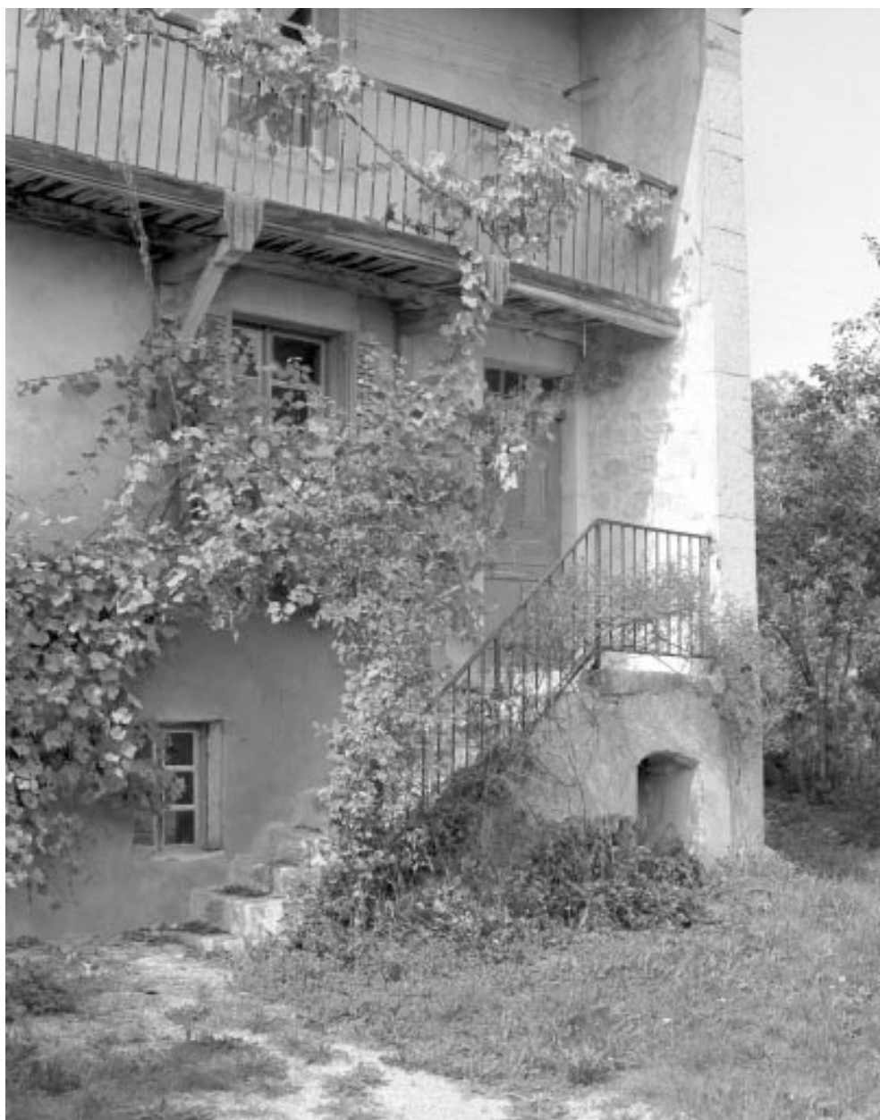
Façade antérieure, accès au logis de droite.
