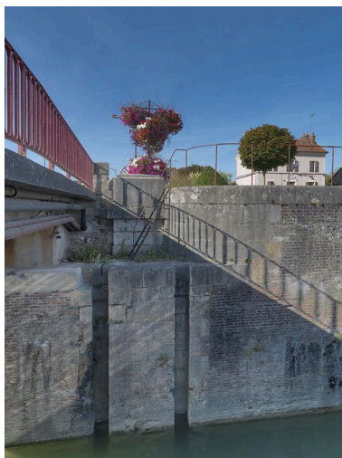
Le pont sur écluse : détail des maçonneries.
