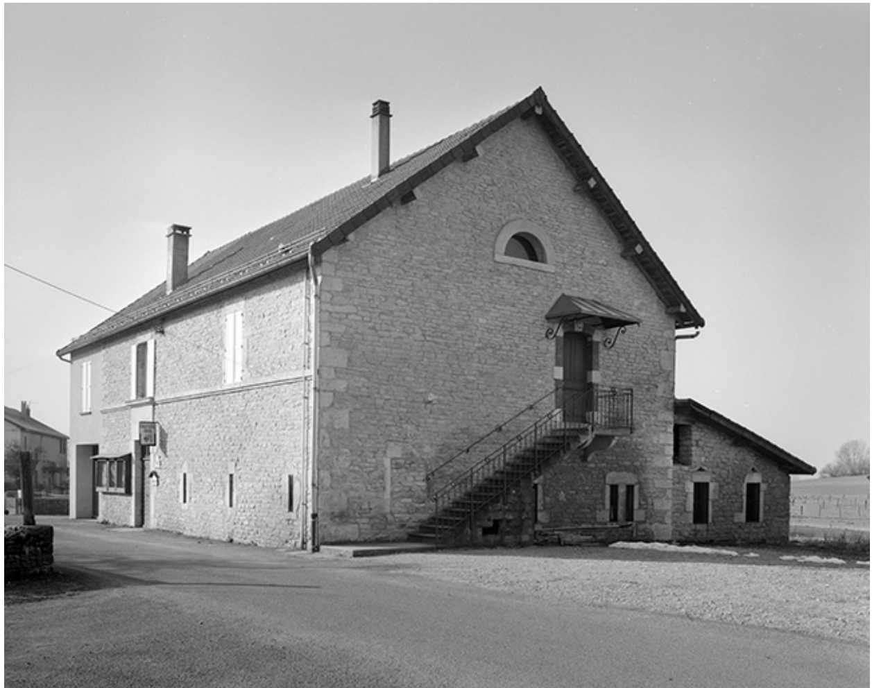
Vue depuis le nord.
