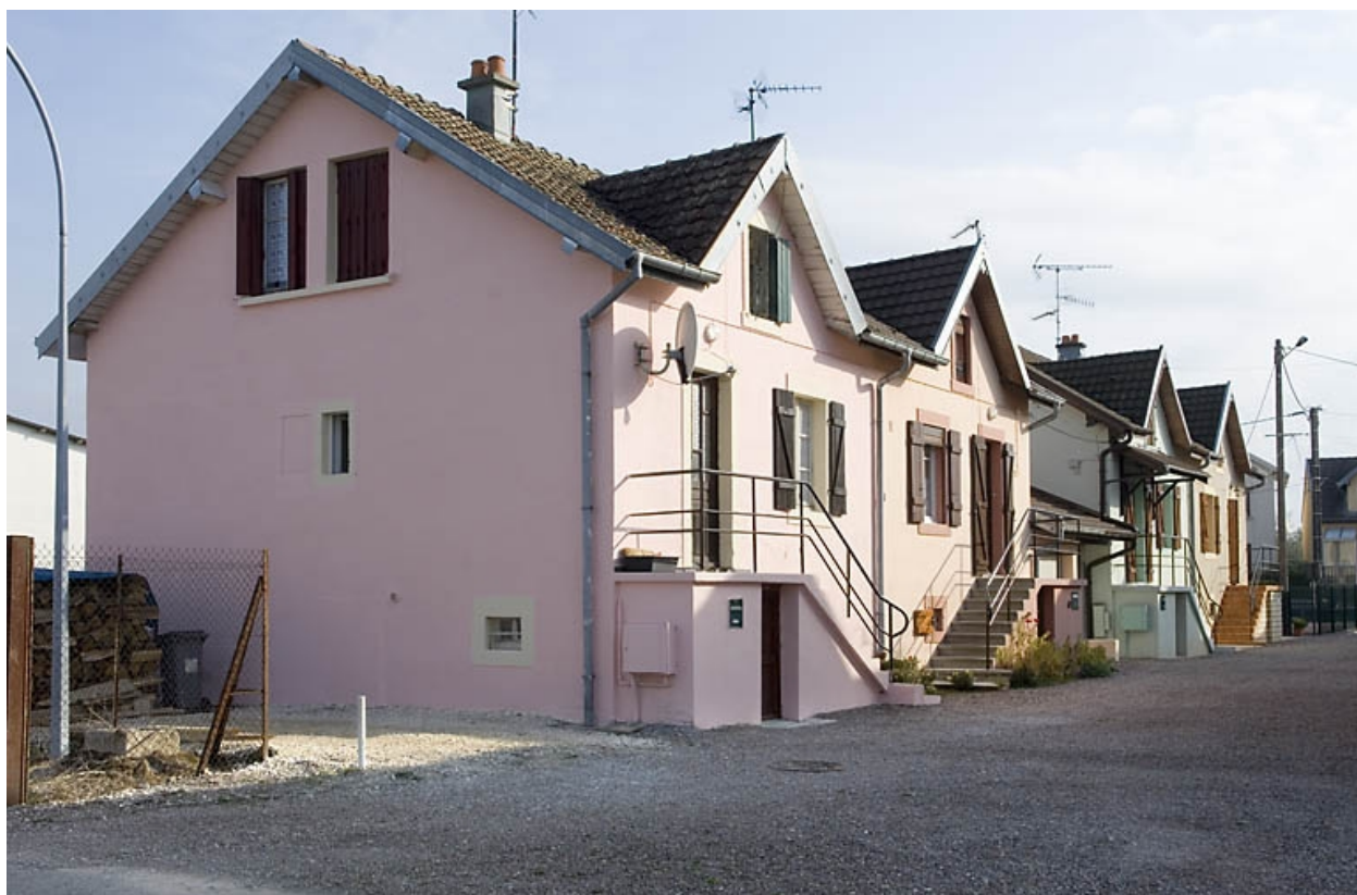
Logements doubles. Vue en enfilade depuis l'ouest.
