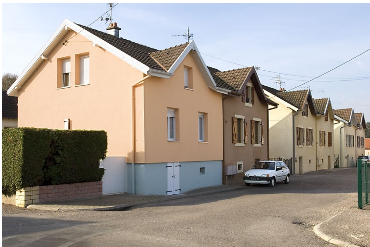
Logements doubles. Façades nord.
