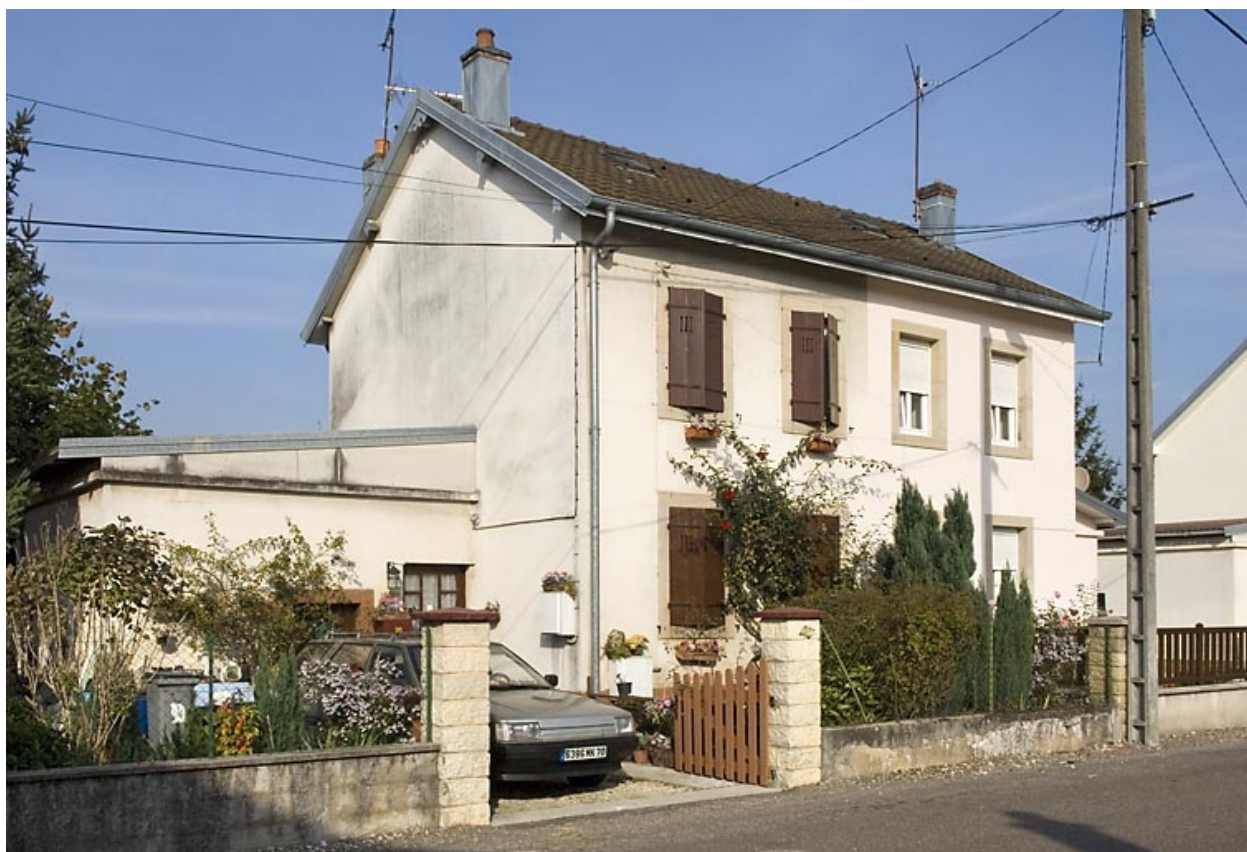
Logement ouvrier à 4 logements (rue Saint-Quentin).
