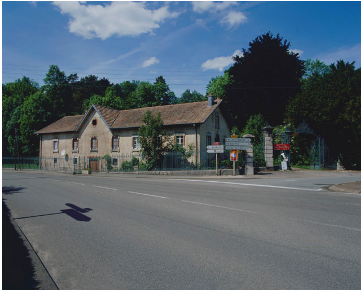
La conciergerie et l'entrée du parc.
