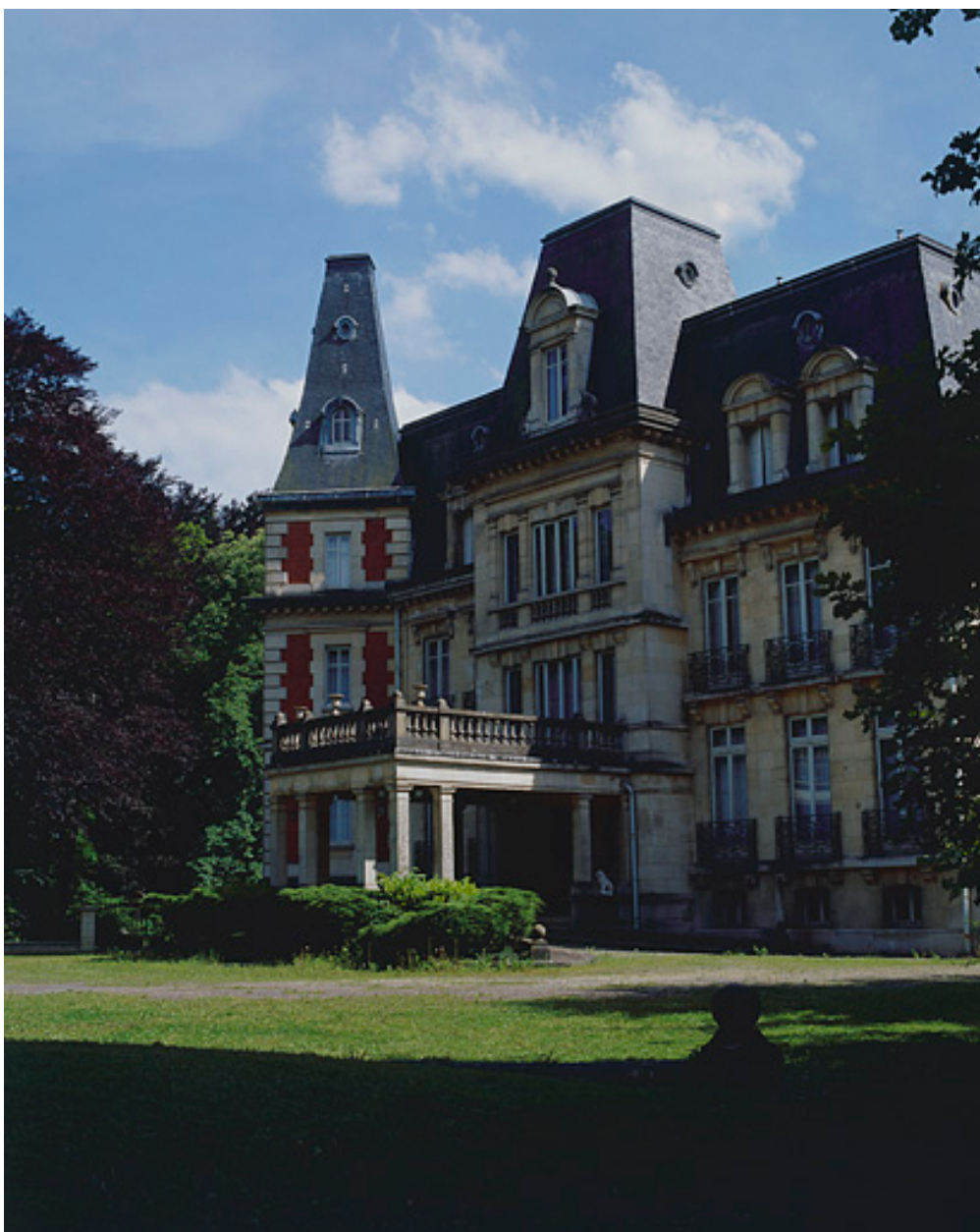
Façade nord vue de trois quarts.
