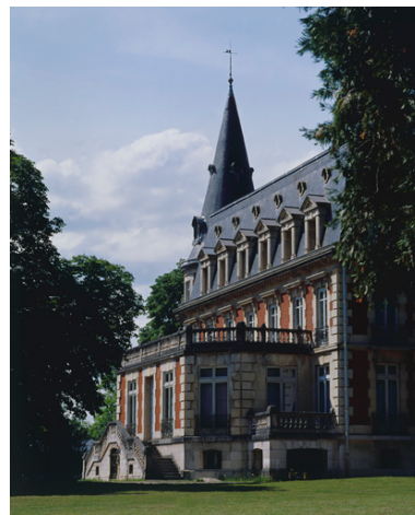
Façade sud vue de trois quarts. Phot. Yves Sancey IVR43_20029000404XA
