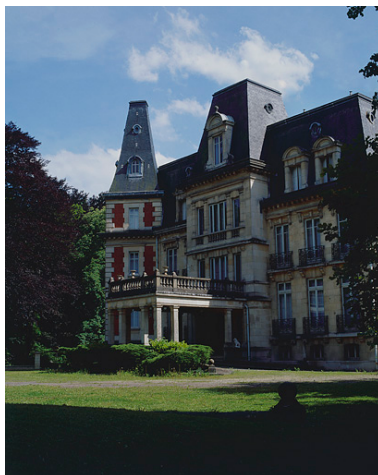
Façade nord vue de trois quarts. Phot. Yves Sancey IVR43_20029000408XA
