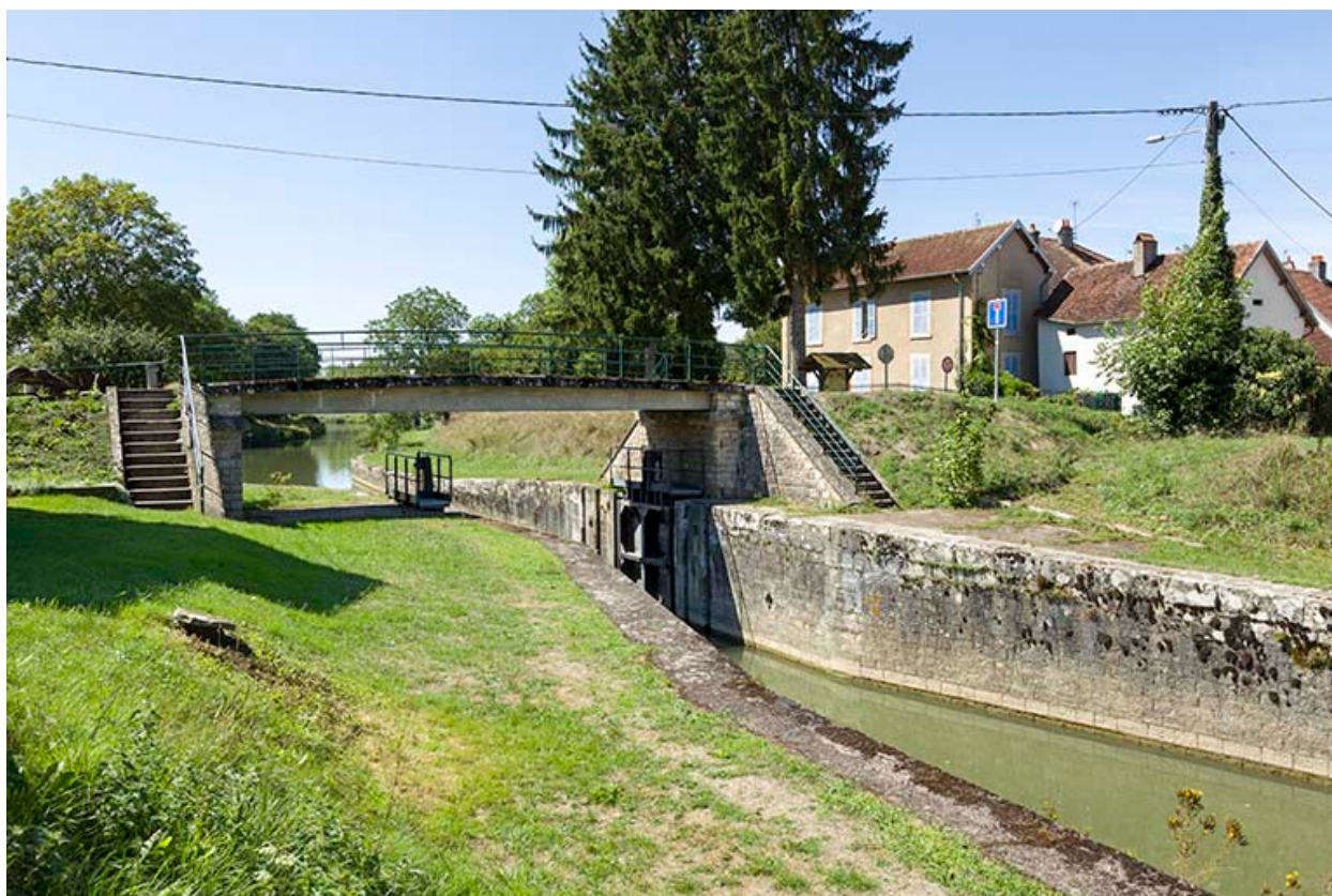
Vue amont de la porte de garde.
