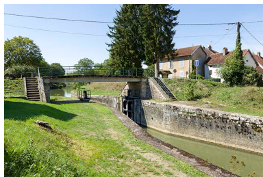
Vue amont de la porte de garde. Phot. Sonia Dourlot IVR43_20167001829NUC2A
