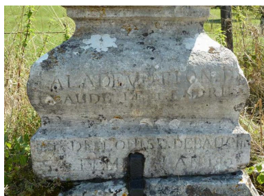
Détail du socle Phot. Sabrina Dalibard IVR43_20137000793NUC2A
