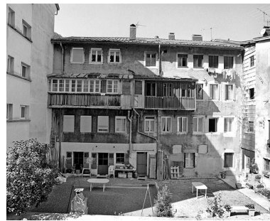
Bâtiment au n° 23 : élévation côté Bienne. Phot. Yves Sancey IVR43_20033900450X
