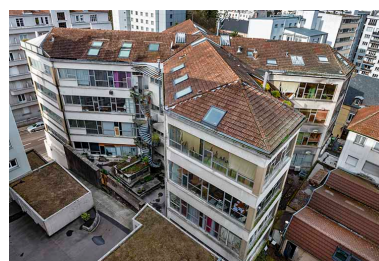
Vue plongeante sur l'immeuble. Phot. Jérôme Mongreville IVR43_20192500129NUC4A
