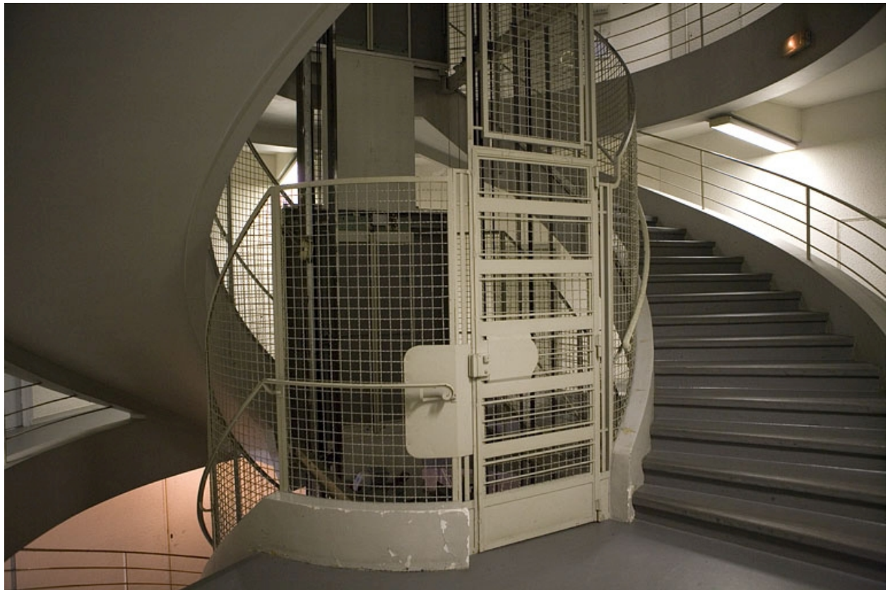
La cage de l'ascenseur entre deux étages.
