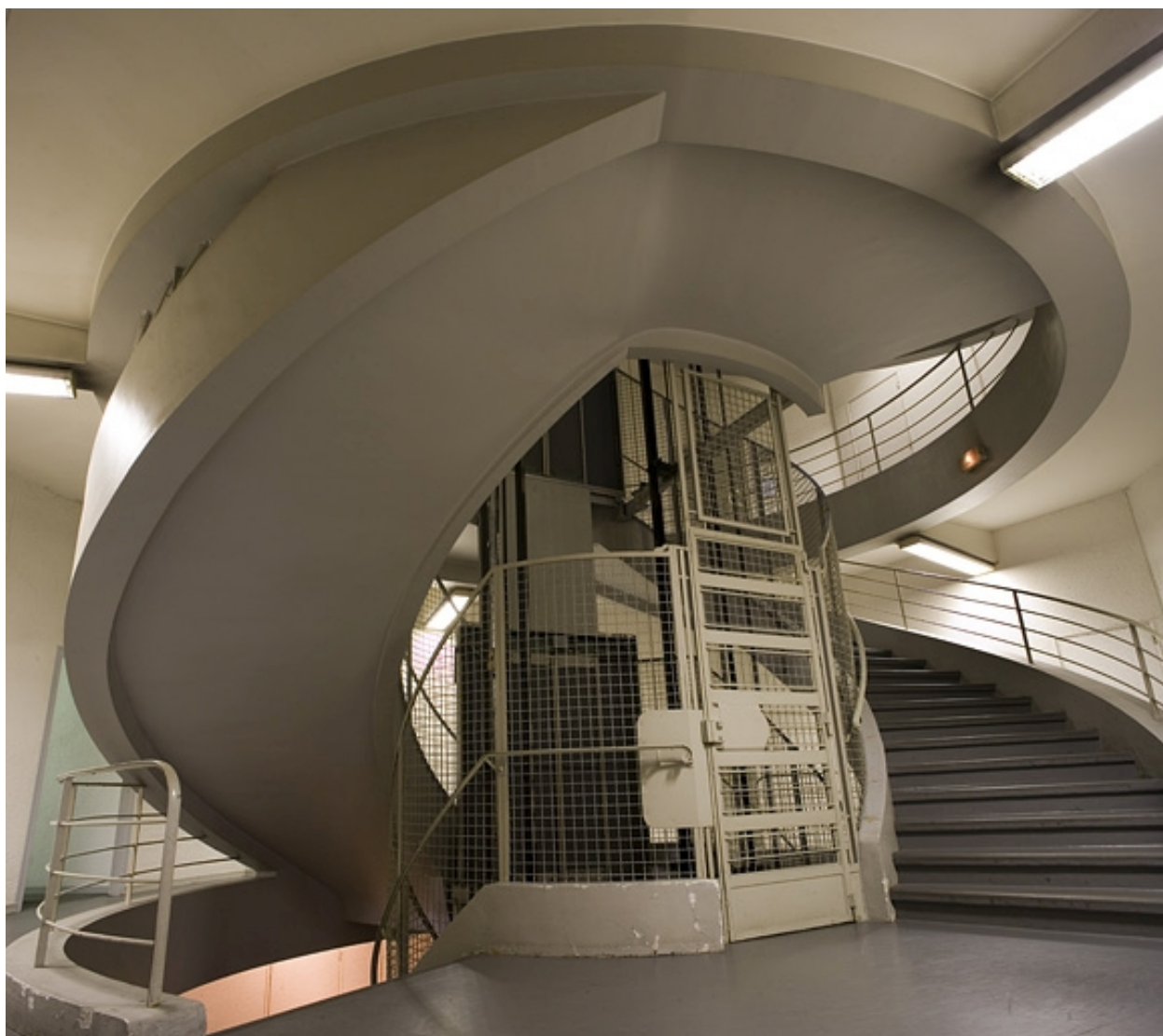
Escalier à double révolution.
