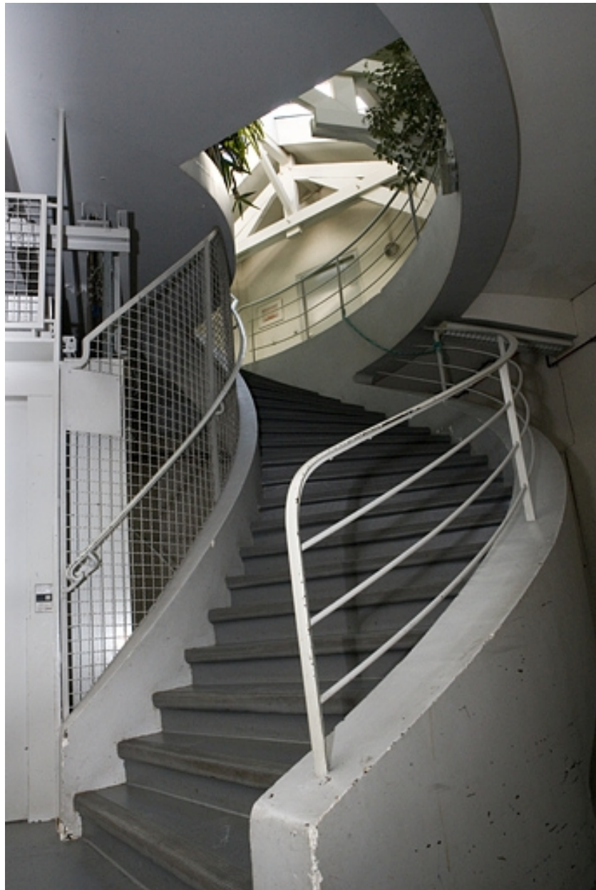
Volée d'escalier du quatrième étage.
