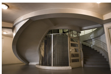
Escalier à double révolution. Phot. Yves Sancey IVR43_20062500601NUCA
