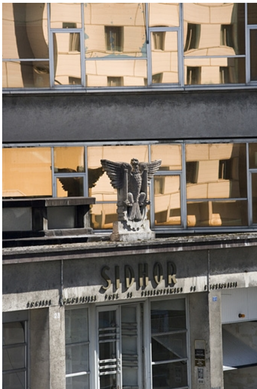
Détail de la façade, vue de trois quarts gauche (cadrage vertical).
