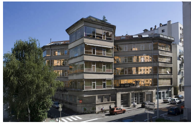
Vue d'ensemble depuis l'ouest en 2006. Phot. Yves Sancey IVR43_20062500593NUCA
