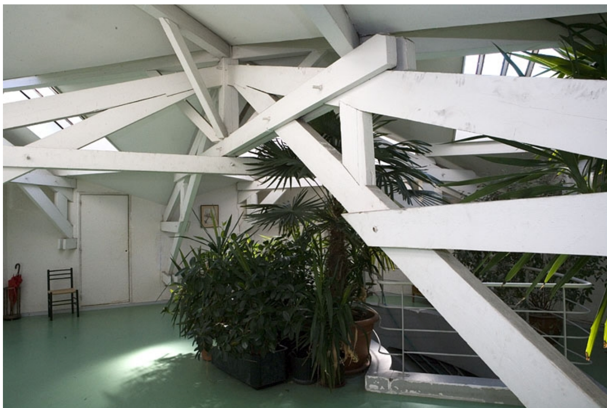
Vue partielle de la charpente au centre du bâtiment.
