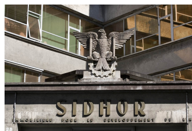
Fronton de la porte d'entrée. Phot. Yves Sancey IVR43_20062500610NUCA
