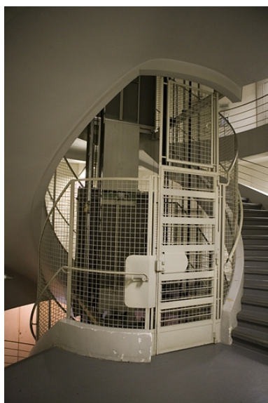
Cage d'ascenseur (cadrage vertical). Phot. Yves Sancey IVR43_20062500604NUCA
