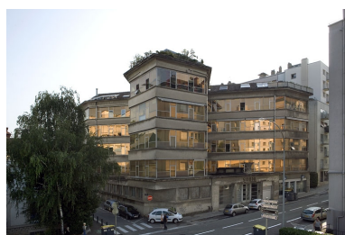
Vue d'ensemble depuis l'ouest en 2006. Phot. Yves Sancey IVR43_20062500592NUCA
