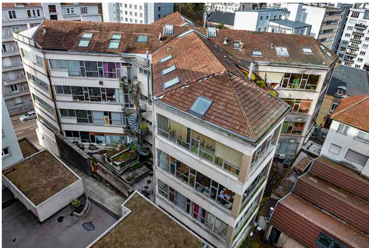
Vue plongeante sur l'immeuble.
