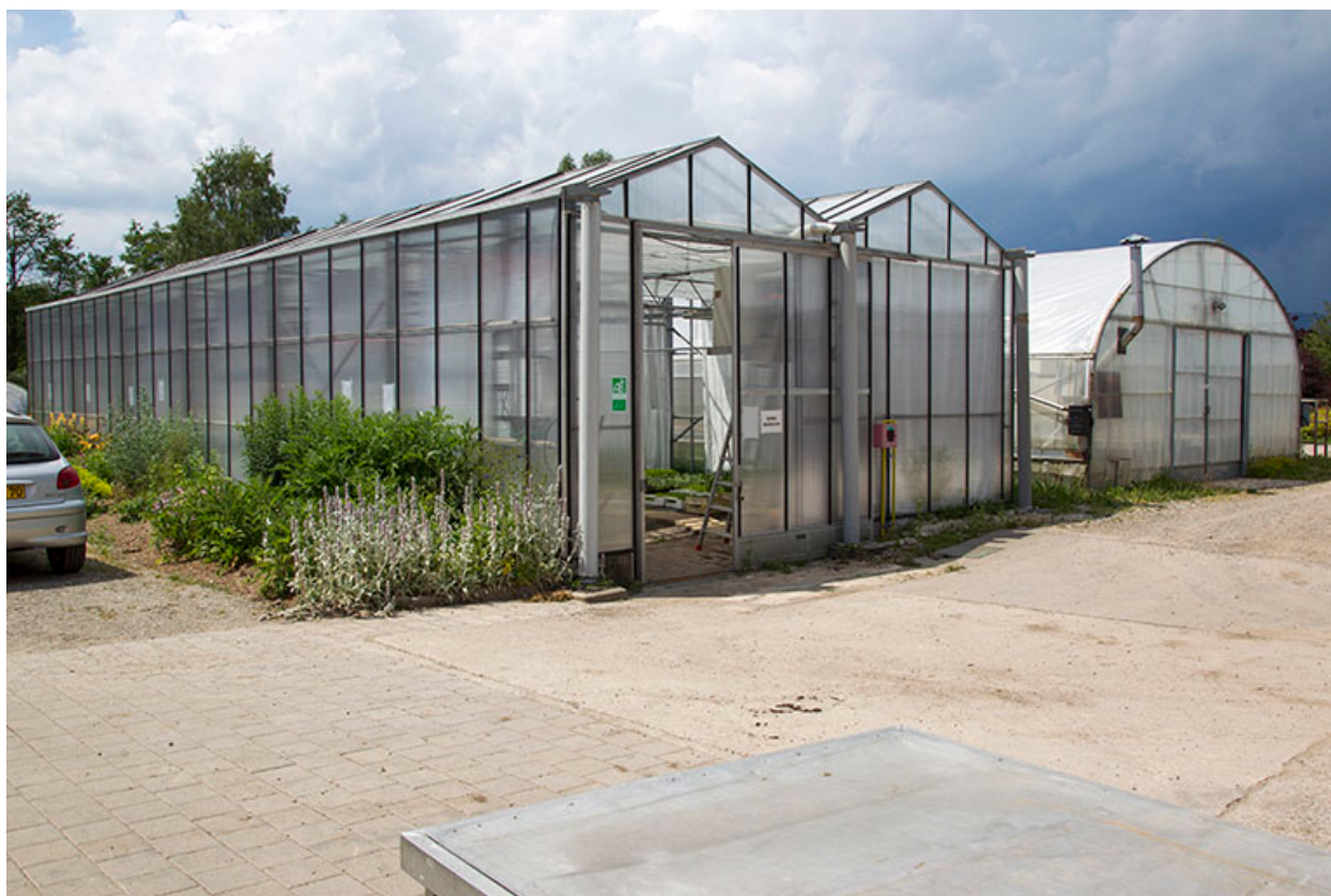
Serres au nord-ouest vues du sud-est.
