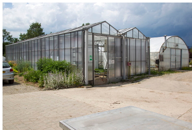
Serres au nord-ouest vues du sud-est. Phot. Jérôme Mongreville IVR43_20149000211NUC2A
