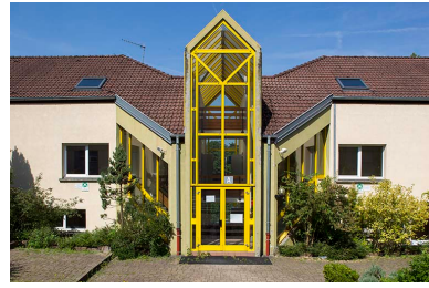
Entrée de l'externat sud-ouest. Phot. Jérôme Mongreville IVR43_20149000174NUC2A
