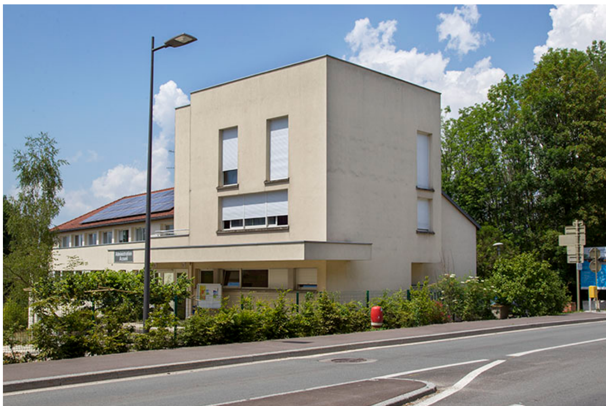
Angle sud-est de l'administration et des logements.
