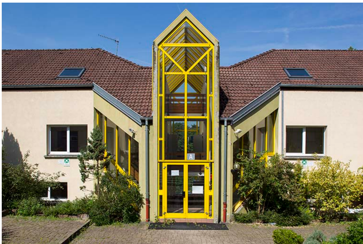
Entrée de l'externat sud-ouest.
