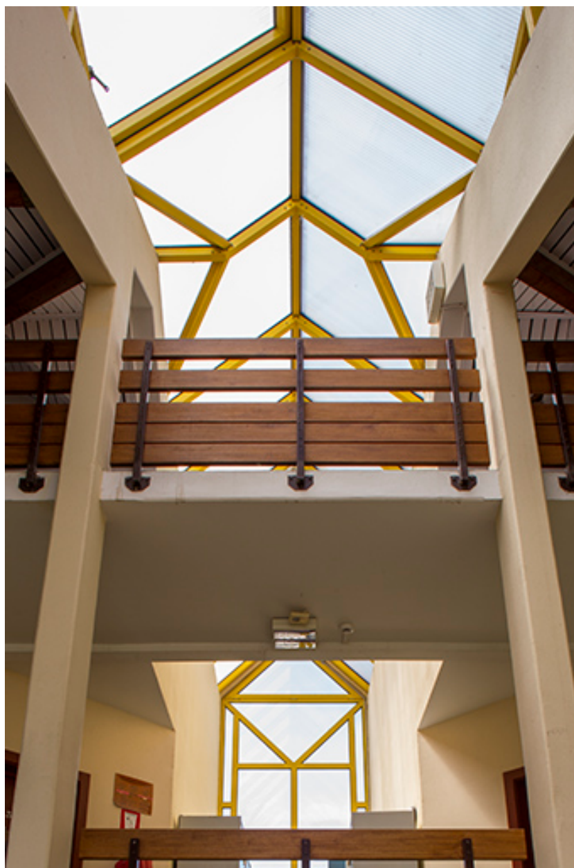
Détail intérieur de l'entrée de l'externat sud-ouest.
