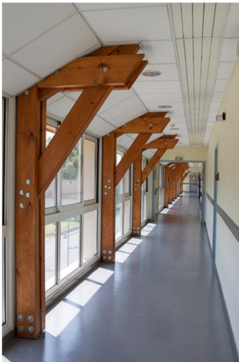
Détail de circulation intérieure de l'externat nord-est.
