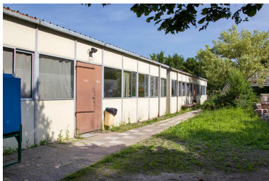
Façade postérieure des salles de cours nord-est. Phot. Jérôme Mongreville IVR43_20149000208NUC2A
