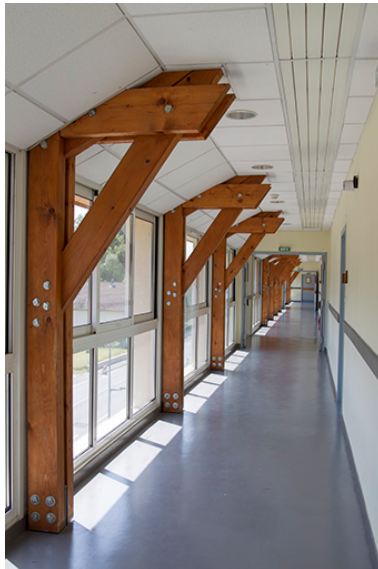
Détail de circulation intérieure de l'externat nord-est.
