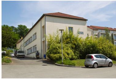
Angle nord-ouest de l'administration et des logements.
