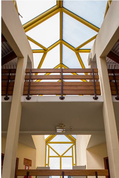
Détail intérieur de l'entrée de l'externat sud-ouest. Phot. Jérôme Mongreville IVR43_20149000175NUC2A
