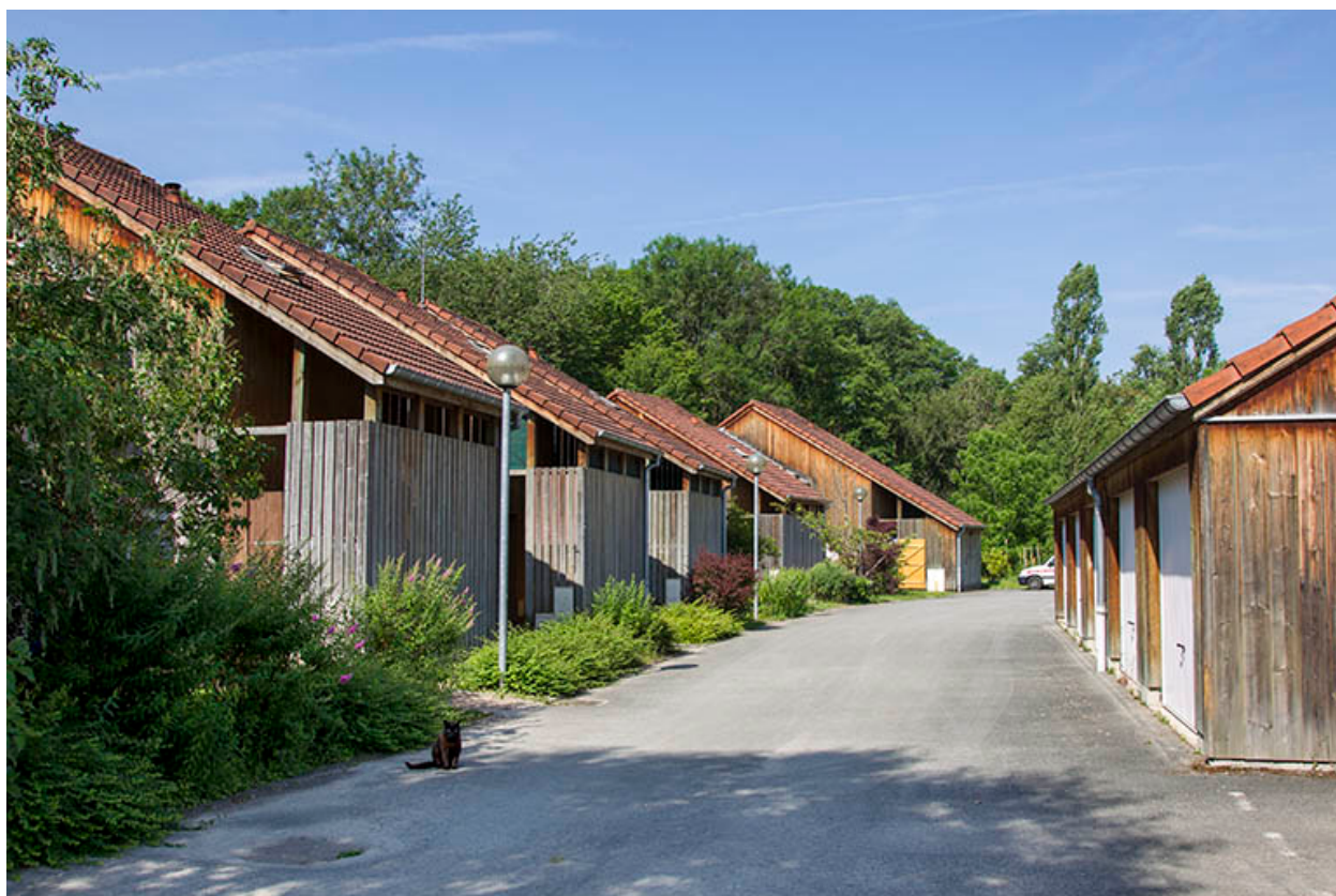
Façades nord des logements du site d'exploitation.
