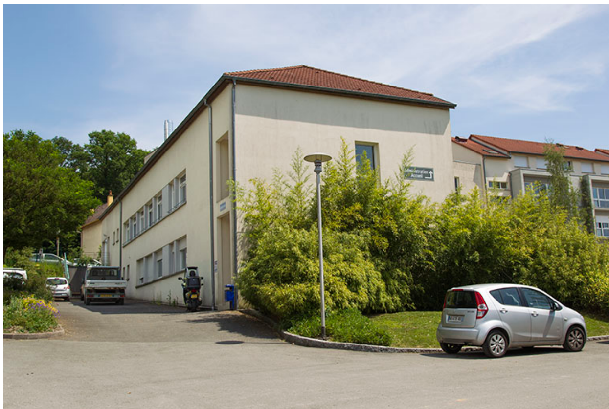
Angle nord-ouest de l'administration et des logements.
