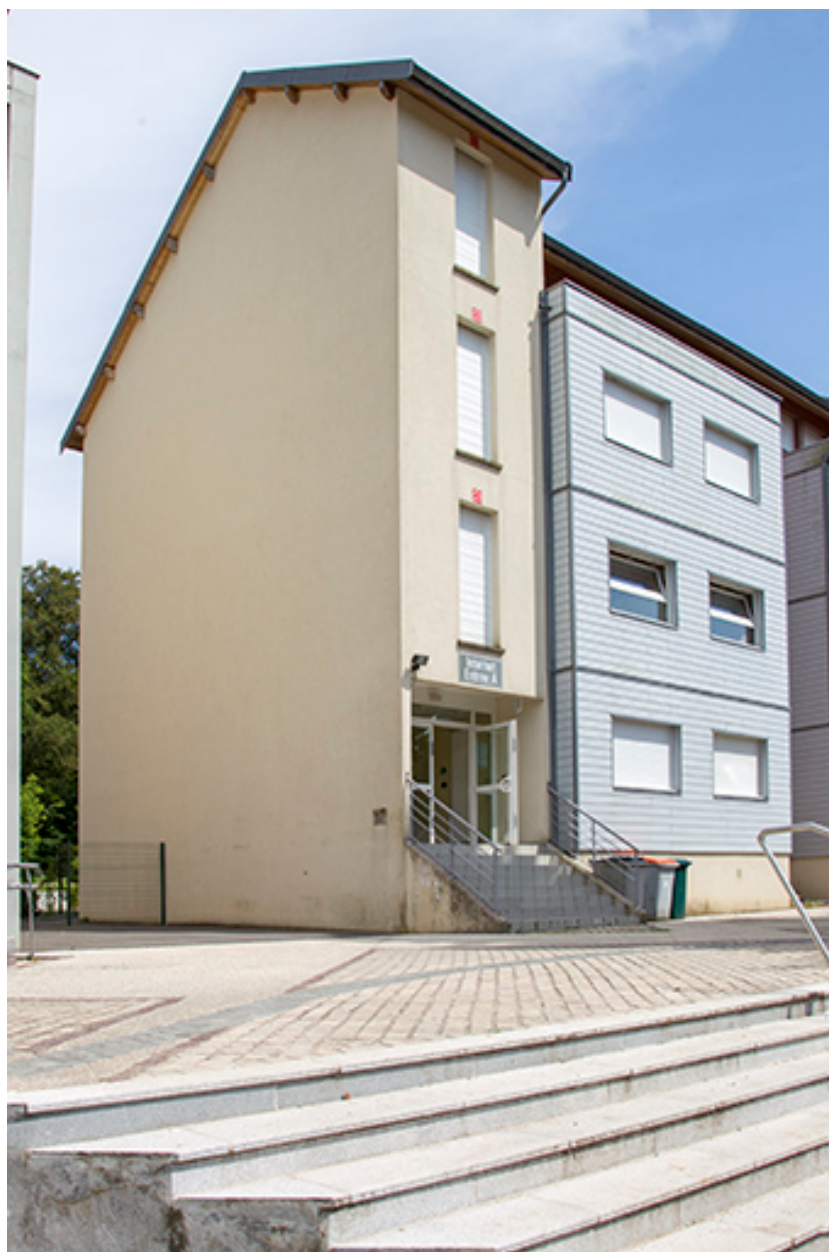
Entrée à l'angle nord-ouest de l'internat.
