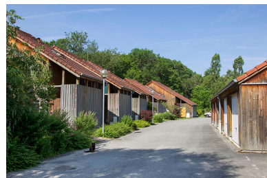
Façades nord des logements du site d'exploitation. Phot. Jérôme Mongreville IVR43_20149000199NUC2A
