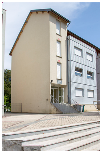
Entrée à l'angle nord- ouest de l'internat. Phot. Jérôme Mongreville IVR43_20149000191NUC2A
