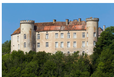
Vue générale de la façade est. Phot. Sonia Dourlot IVR43_20157001574NUC2A
