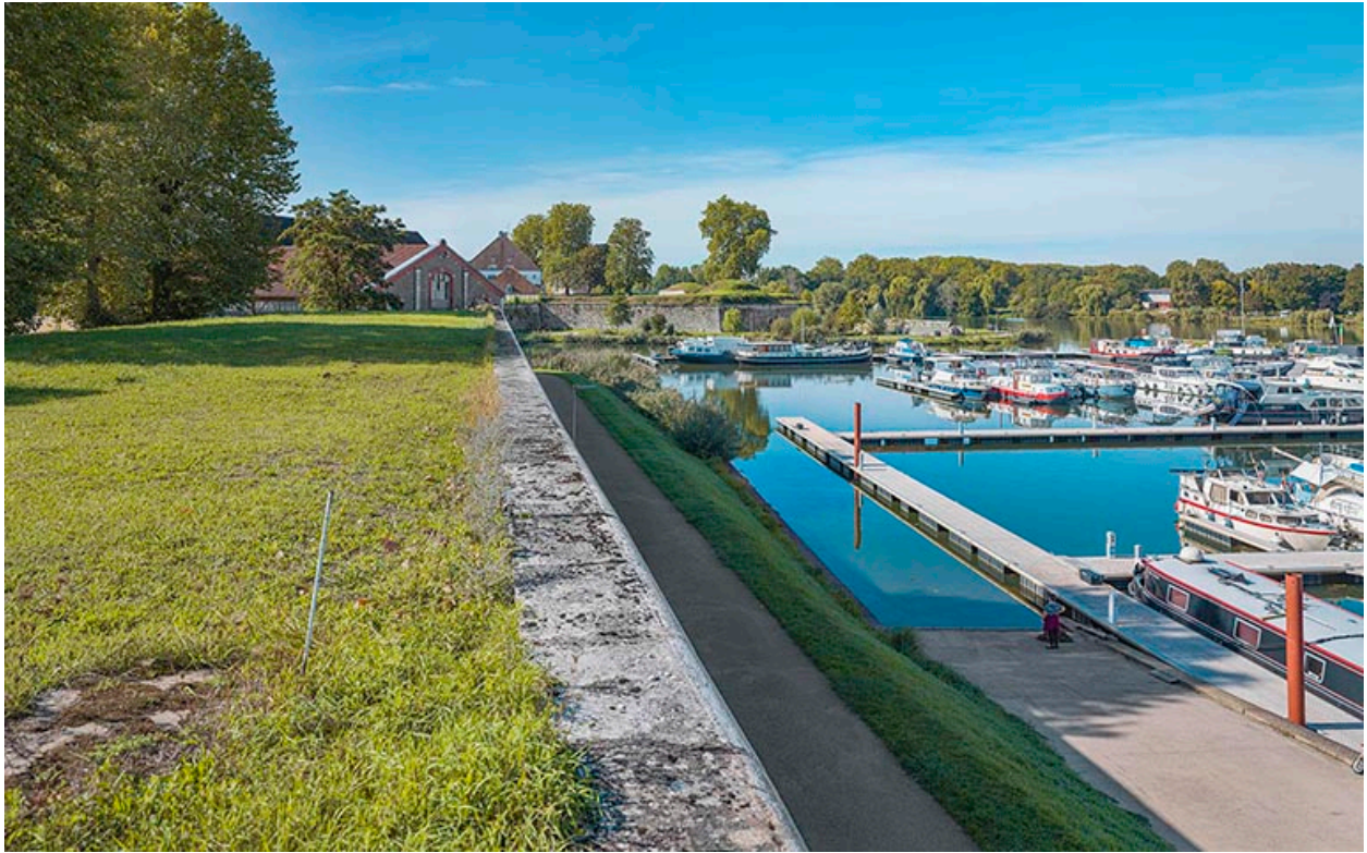
Terre-plein, parapet (face ouest).
