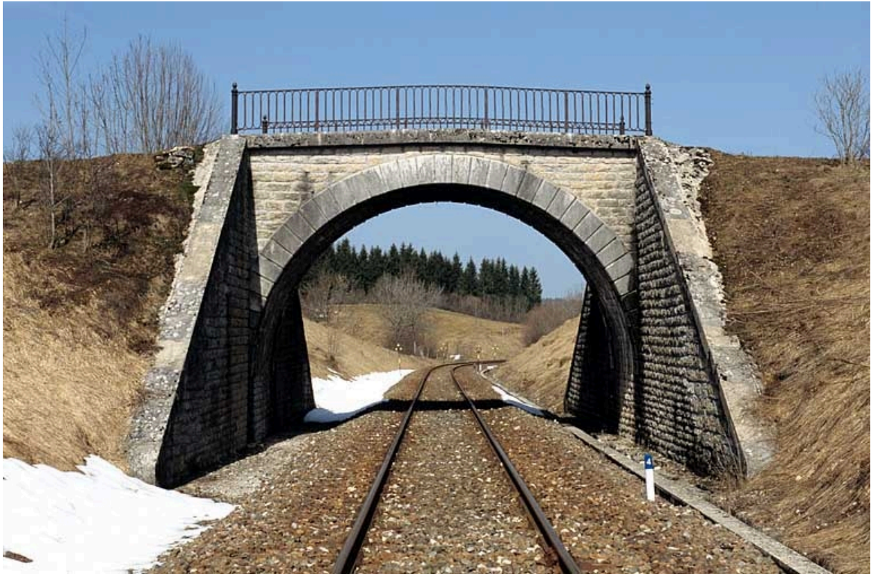
Vue d'ensemble depuis la voie (côté La Cluse).
