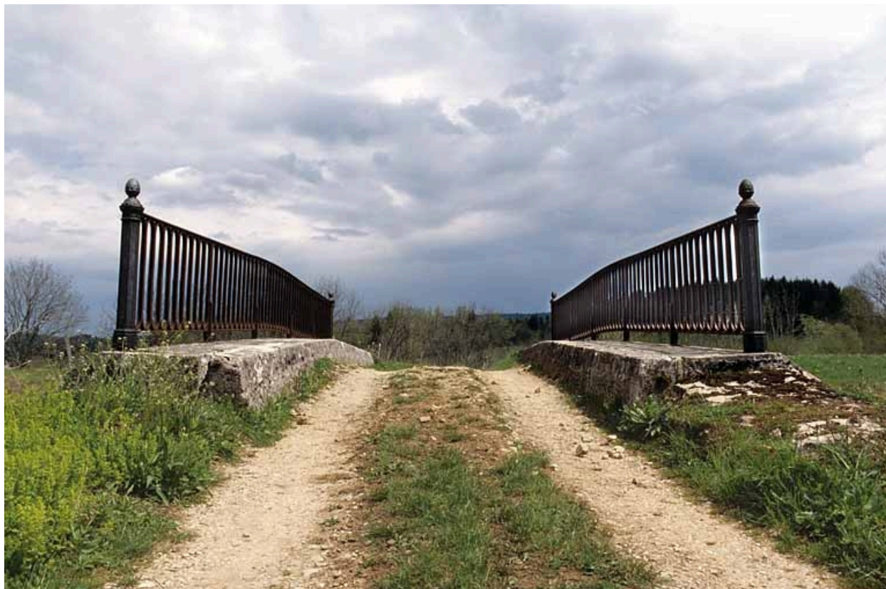
Tablier en dos-d'âne.
