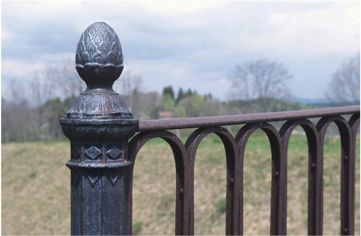
Motif d'amortissement d'un potelet du garde-corps.
