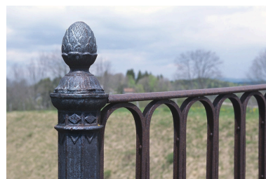
Motif d'amortissement d'un potelet du garde-corps. Phot. Yves Sancey IVR43_20053900257ZA
