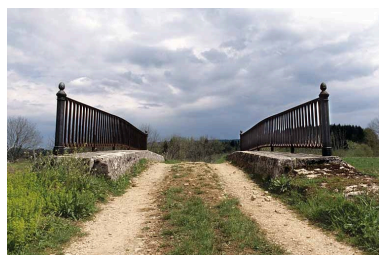
Tablier en dos-d'âne. Phot. Yves Sancey IVR43_20053900256ZA
