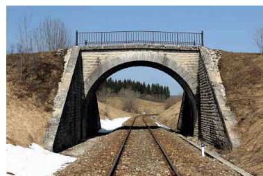
Vue d'ensemble depuis la voie (côté La Cluse). Phot. Yves Sancey IVR43_20053900259ZA
