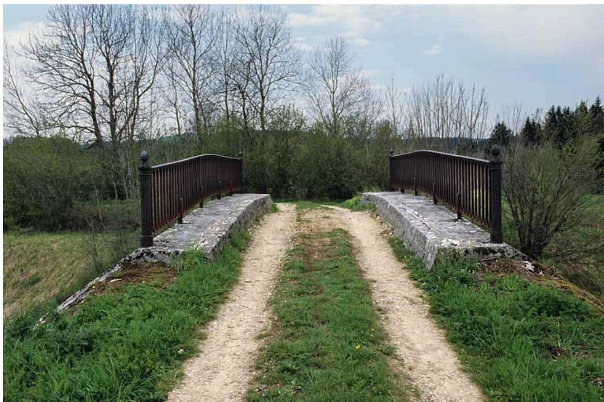
Vue d'ensemble du tablier.
