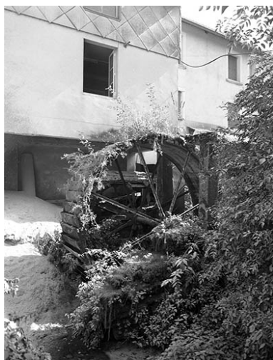
Roue hydraulique sur la façade postérieure. Phot. Yves Sancey IVR43_19973901133X
