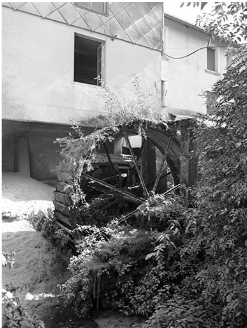
Roue hydraulique sur la façade postérieure.
