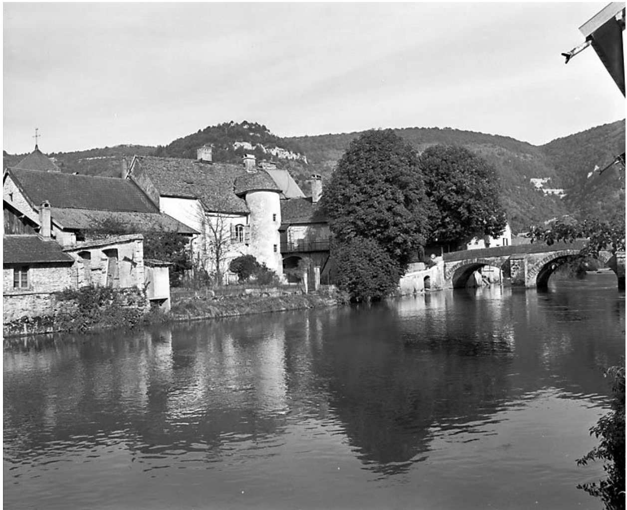
Façade postérieure sur la Loue.
