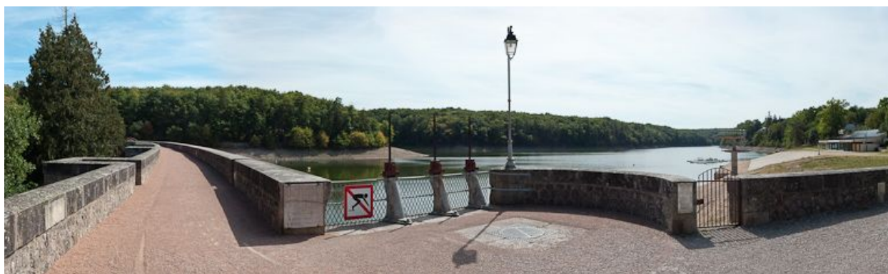
Vue d'ensemble du réservoir.
