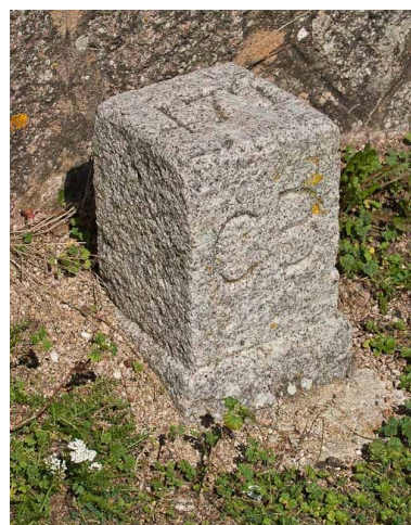
Vue d'une borne du réservoir de Pont. Phot. Pierre-Marie Barbe-Richaud IVR26_20112103654NUC2AQ
