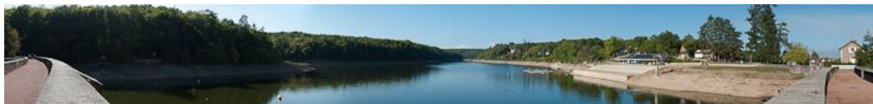
Vue d'ensemble du réservoir.
