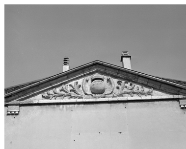
Fronton de pignon sur rue. Phot. Yves Sancey IVR43_19802500143X
