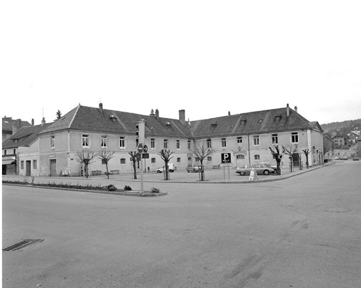
Corps de bâtiment gauche.
