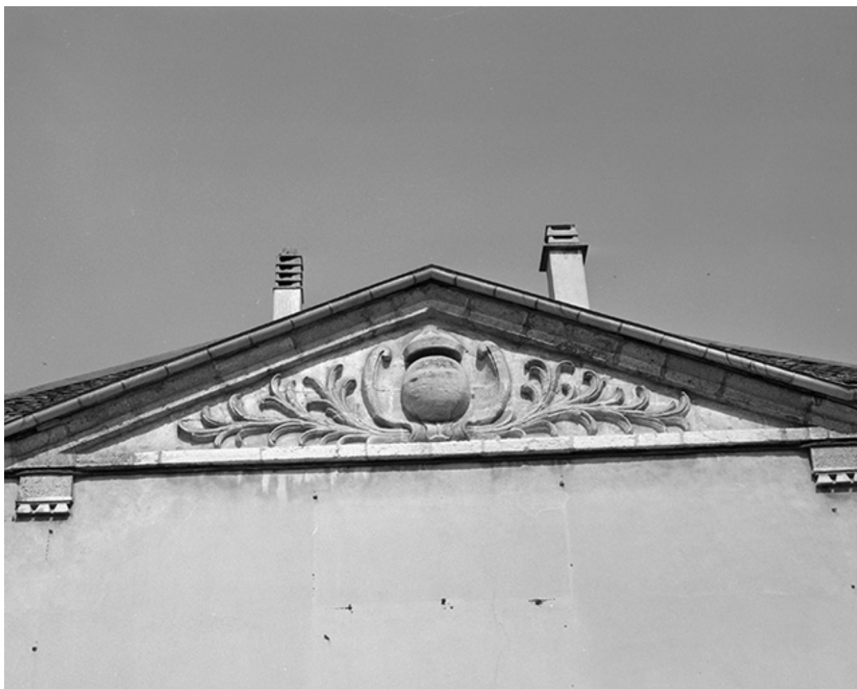
Fronton de pignon sur rue.
