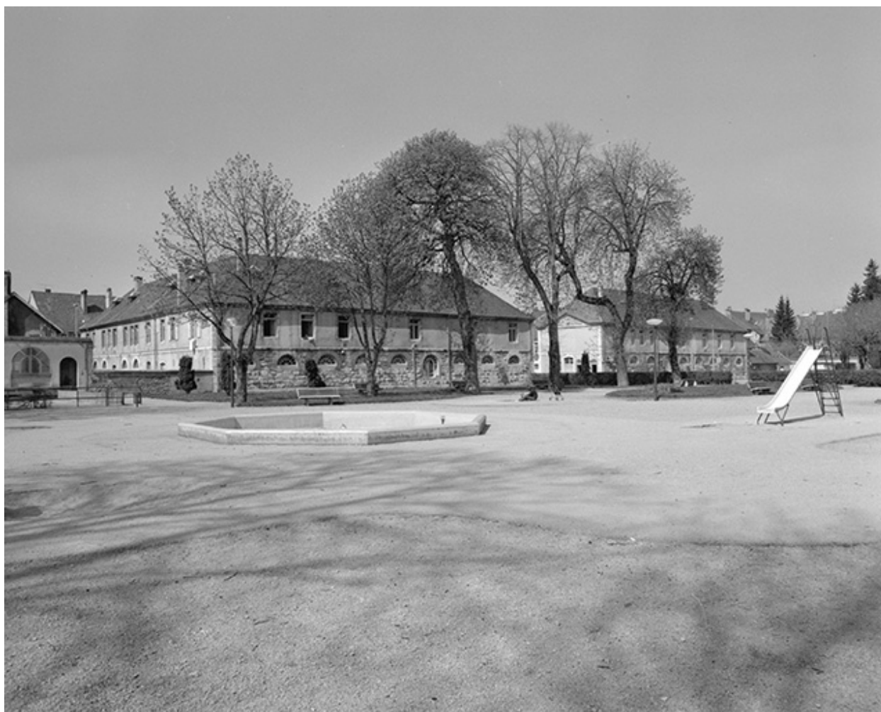
Vue d'ensemble de la façade postérieure.
