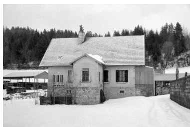
Façade latérale gauche. Phot. Laurent Poupard IVR43_19923901169Z
