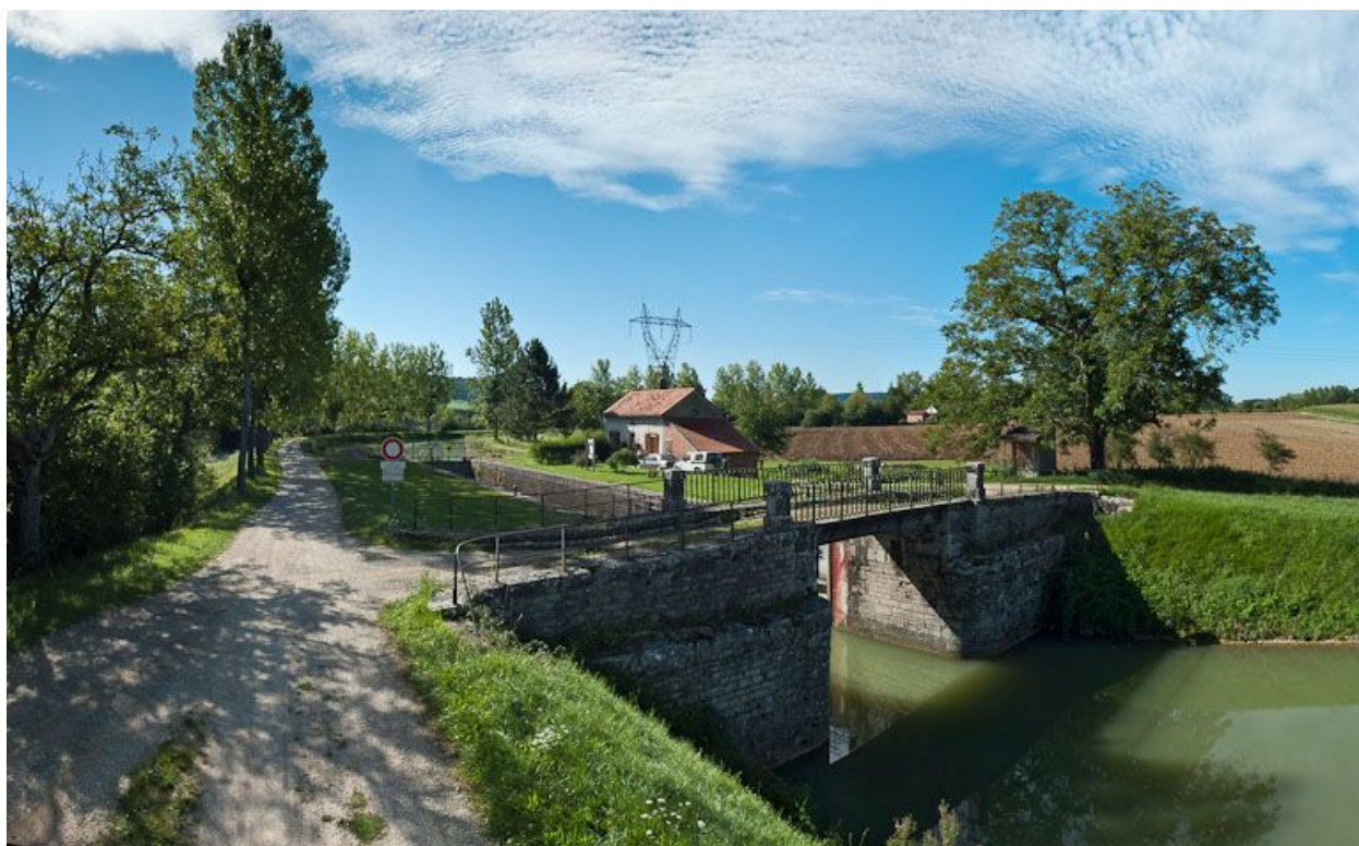
Vue d'ensemble du site d'écluse.
