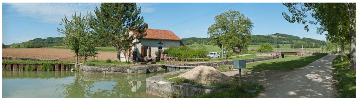
Vue d'ensemble du site d'écluse.
