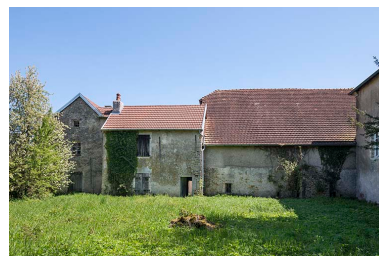
Vue générale depuis le verger. Phot. Jérôme Mongreville IVR43_20177000425NUC4A
