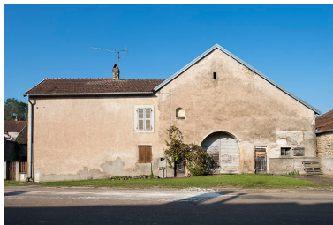
La ferme, "côté rue". Phot. Jérôme Mongreville IVR43_20167001606NUC4A
