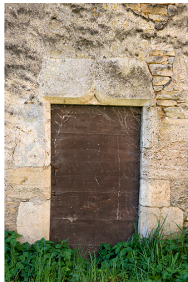
Porte de la grange. Phot. Jérôme Mongreville IVR43_20177000422NUC4A
