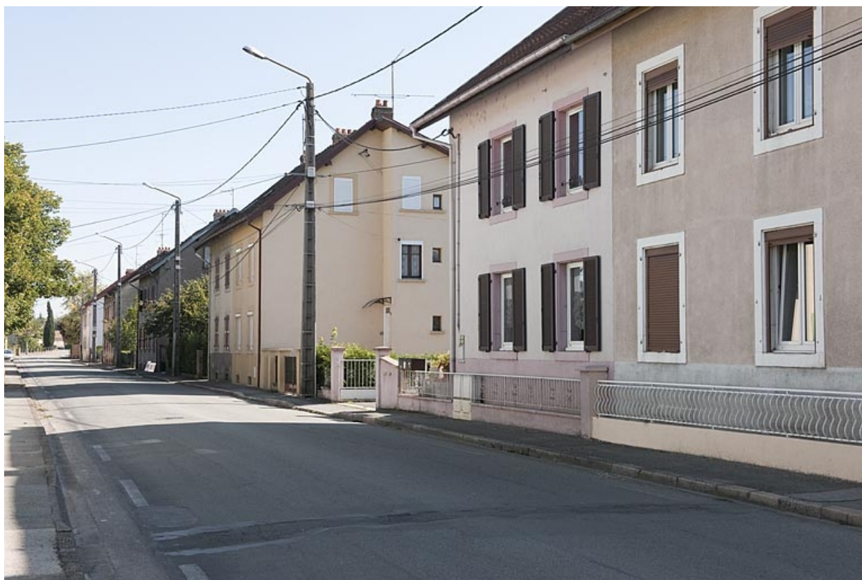
Façades antérieures sur la rue des Mines.
