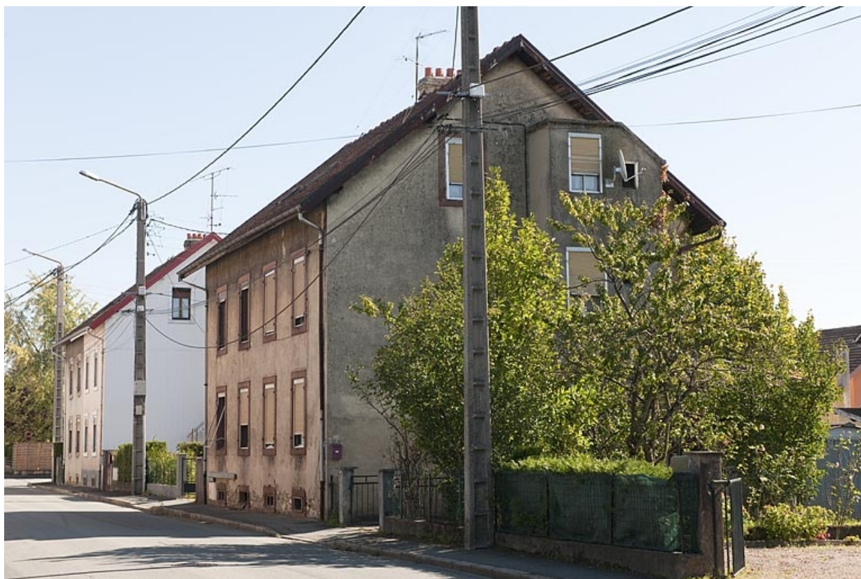
Vue de trois quarts de deux habitations.
