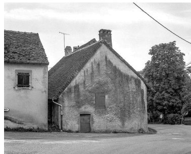
Façade latérale gauche. Phot. Yves Sancey IVR43_19843900072X
