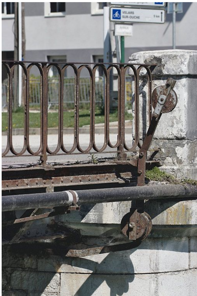
Détail du garde-corps et de la poulie.
