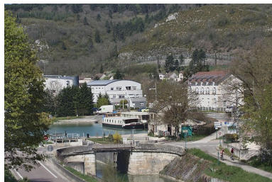
Vue d'ensemble du pont, vu de dessus. Phot. Thierry Kuntz IVR26_20112100026NUC2A
