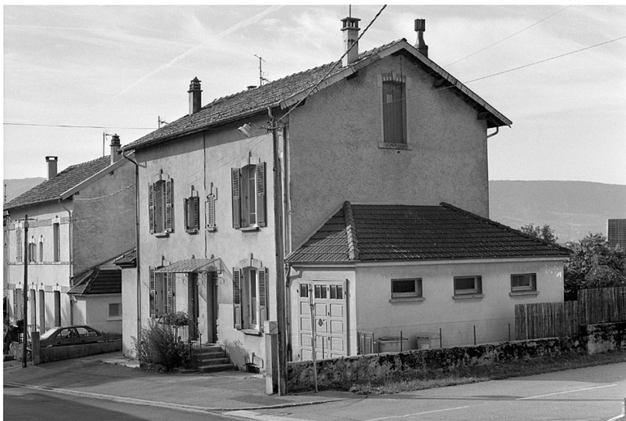
Façade antérieure et face droite.
