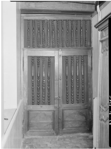
Porte au fond du couloir. Phot. Jean-Luc Duthu IVR26_19872100236V
