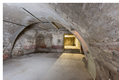
Caves nord : vue depuis l'ouest. Phot. Pierre-Marie Barbe-Richaud IVR26_20238900648NUC4A
