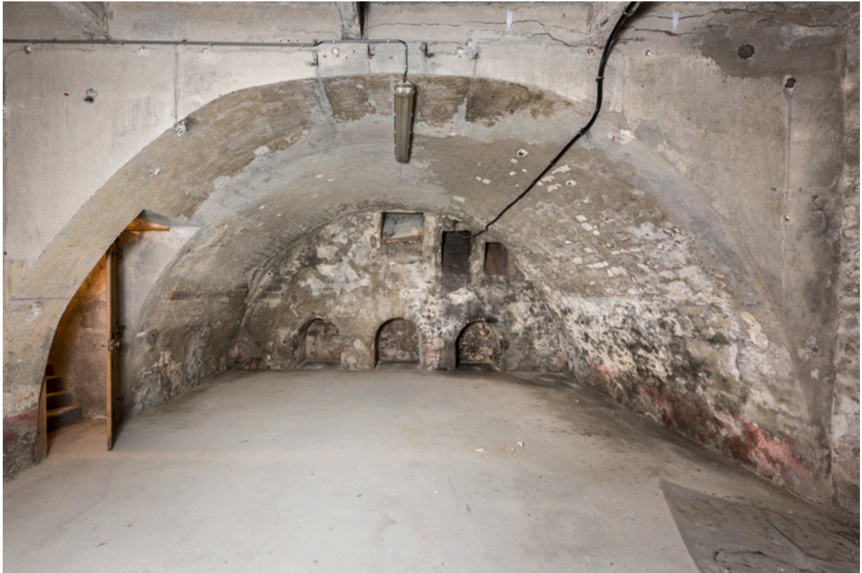
Caves nord : vue depuis l'est.
