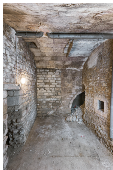
Caves sud : 1re pièce, depuis l'escalier au sud. Au fond, mur pouvant remonter au 12e siècle. Phot. Pierre-Marie Barbe-Richaud IVR26_20238900644NUC4A
