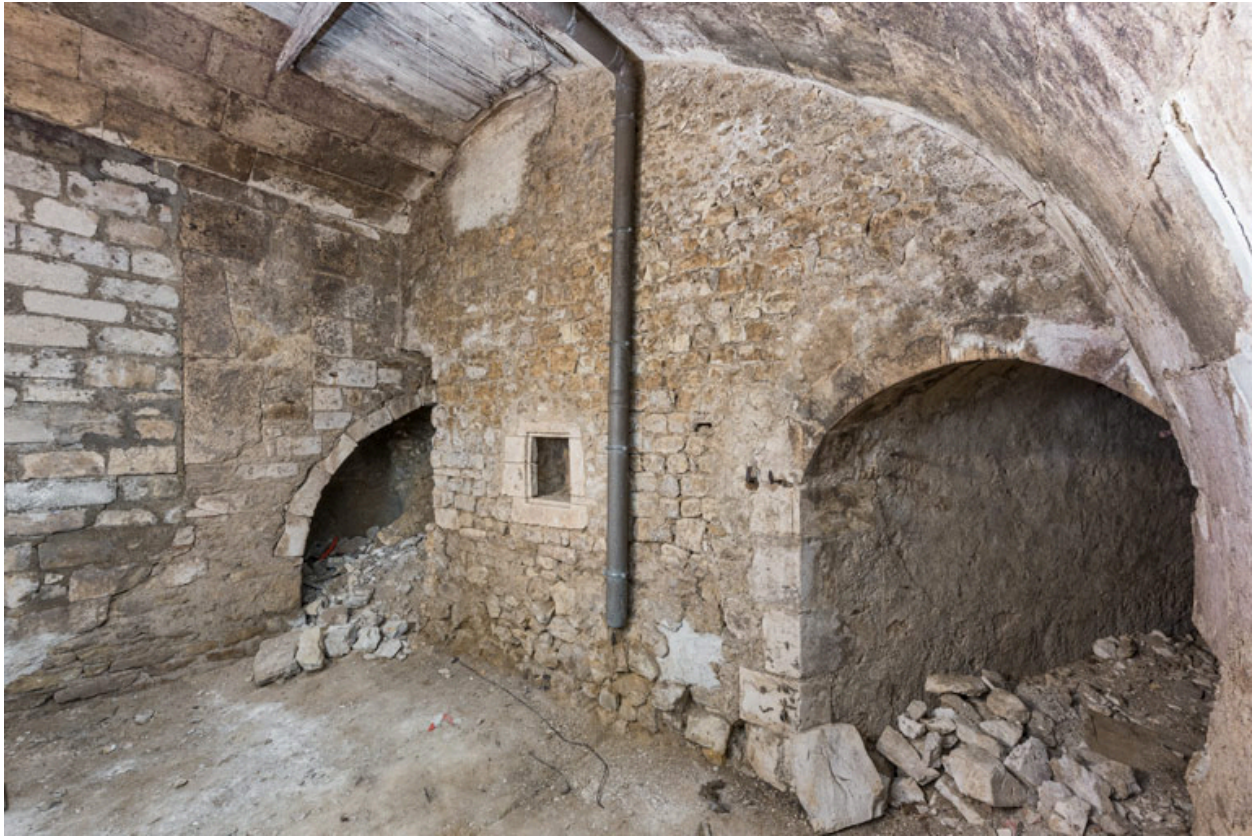
Caves sud : 1re pièce, depuis l'escalier au sud.
