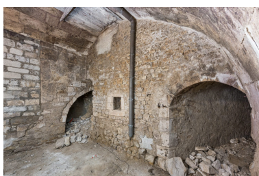
Caves sud : 1re pièce, depuis l'escalier au sud. Phot. Pierre-Marie Barbe-Richaud IVR26_20238900643NUC4A
