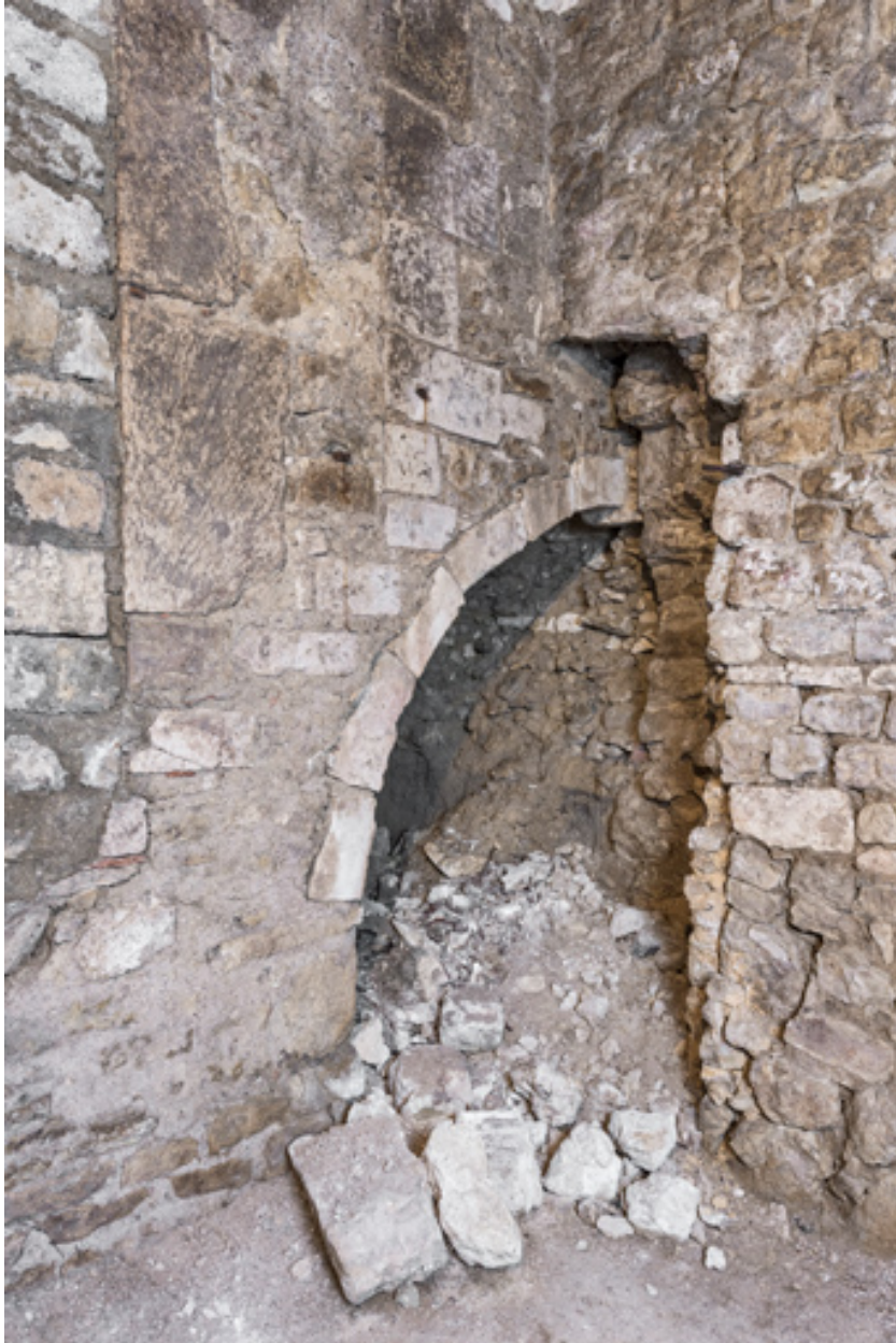
Caves sud, 1re pièce : traces d'escalier dans le mur (12e siècle ?).
