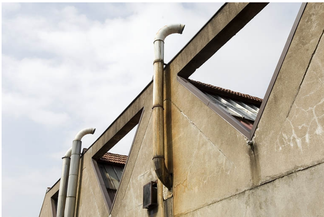
Pignons de l'atelier de fabrication. Détail.
