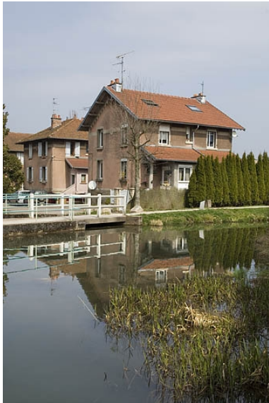
Logements ouvriers vus de trois quarts.
