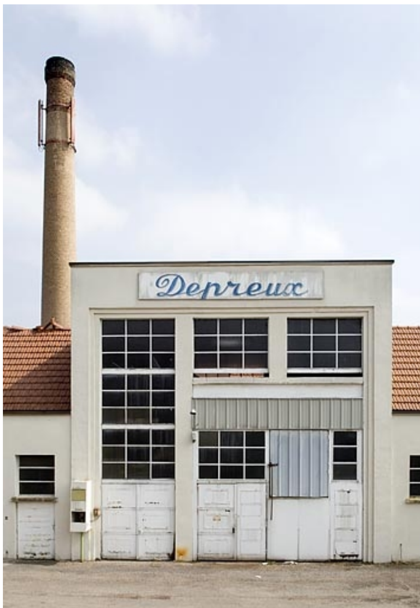
Cheminée et façade antérieure de l'ancienne chaufferie.
