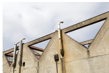
Pignons de l'atelier de fabrication.
