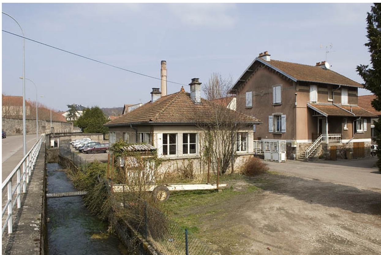
Conciergerie et logement ouvrier depuis le sud-ouest.
