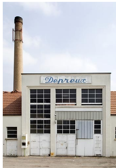
Cheminée et façade antérieure de l'ancienne chaufferie.
