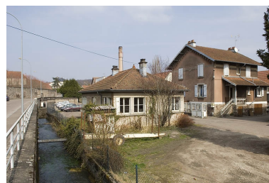
Conciergerie et logement ouvrier depuis le sud-ouest.
