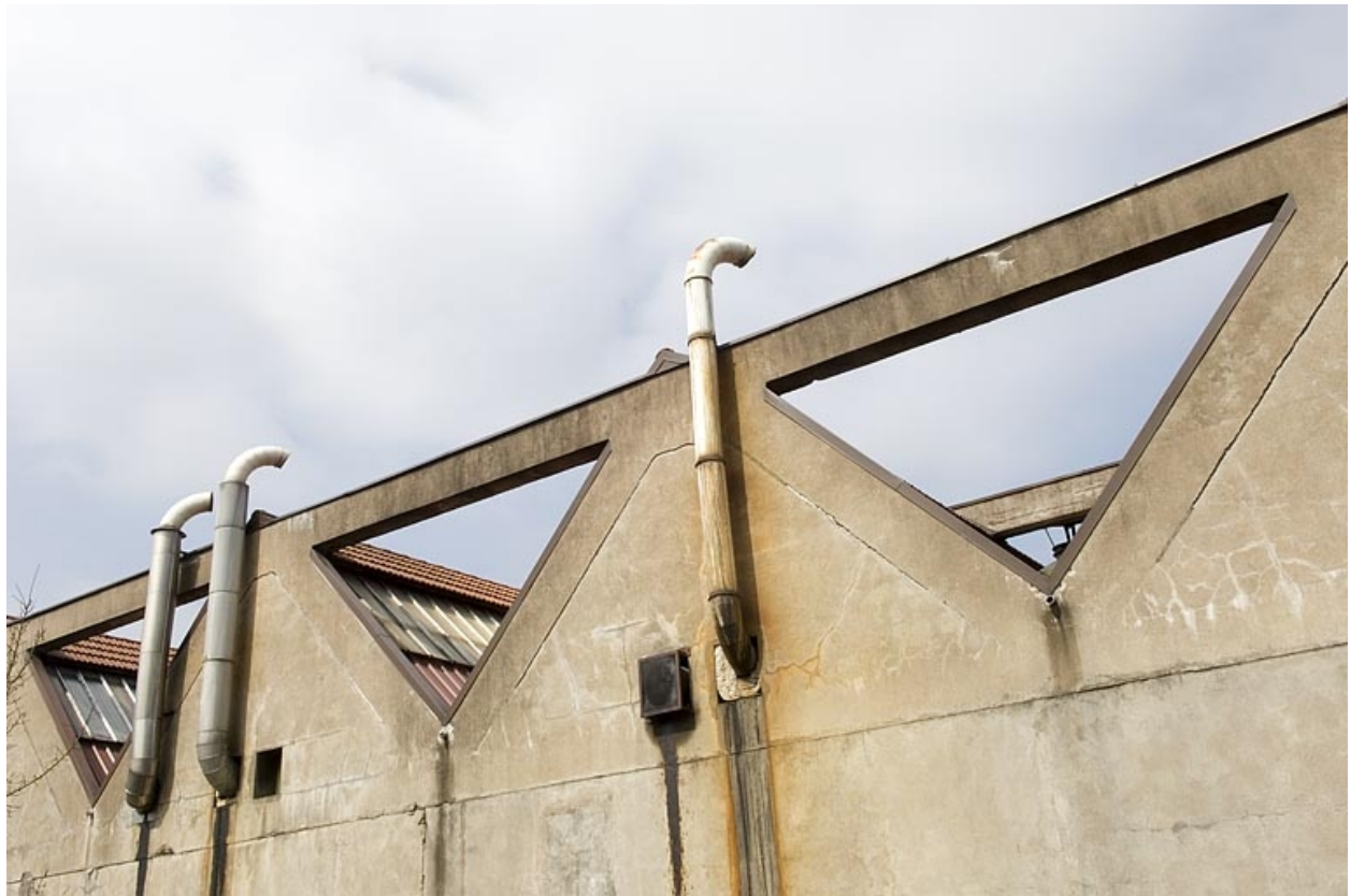
Pignons de l'atelier de fabrication.
