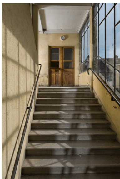
Escalier principal : première volée et guichet sur le repos. Phot. Pierre-Marie Barbe-Richaud IVR26_20257100494NUC4A
