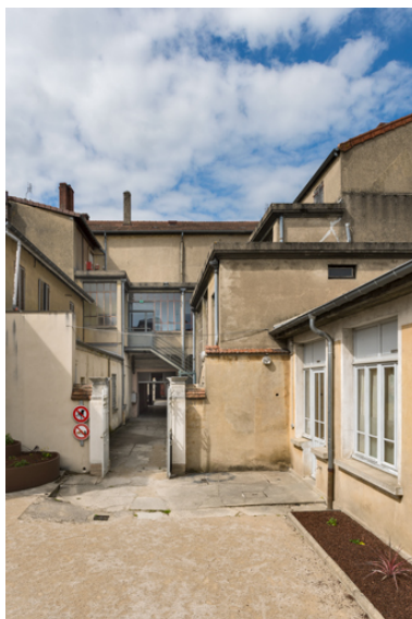
Façade postérieure et dépendances, depuis la deuxième cour au sud. Phot. Pierre-Marie Barbe-Richaud IVR26_20257100492NUC4A
