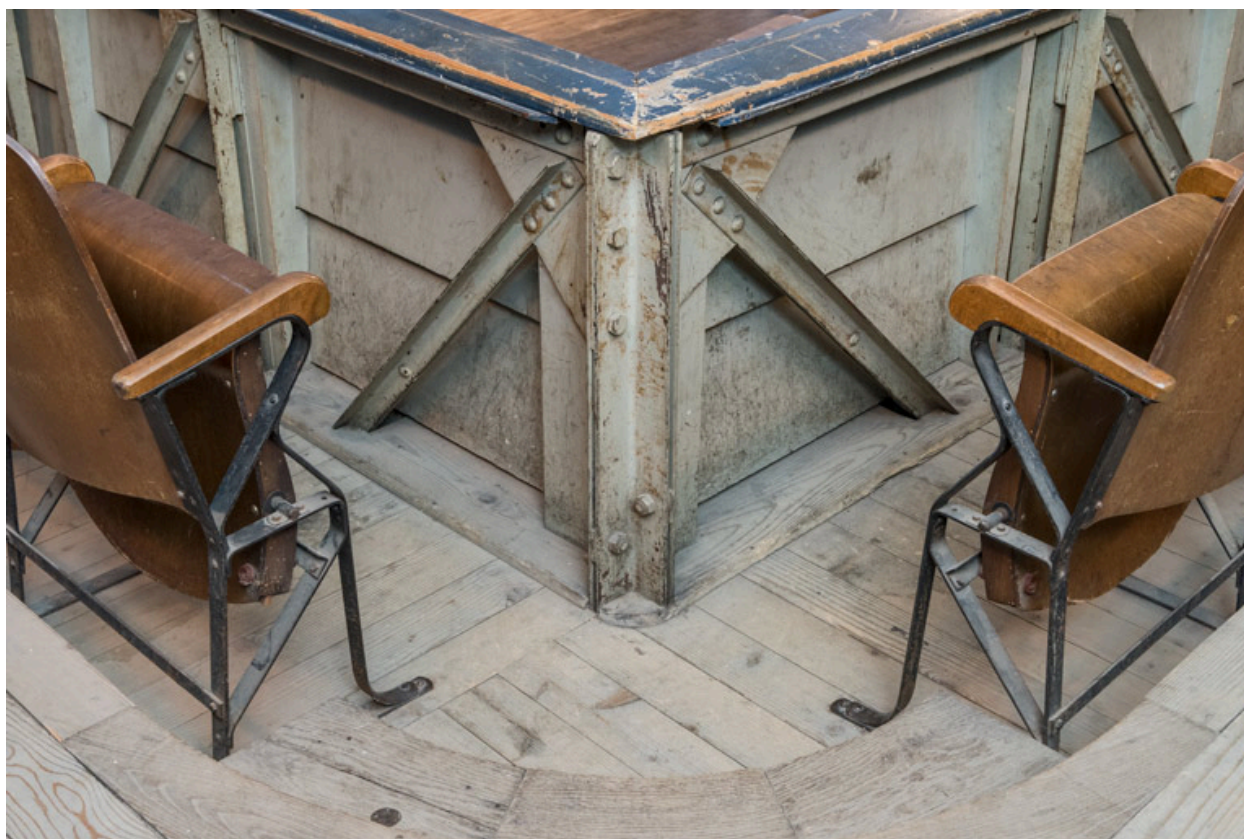
Balcon : structure métallique du garde-corps.
