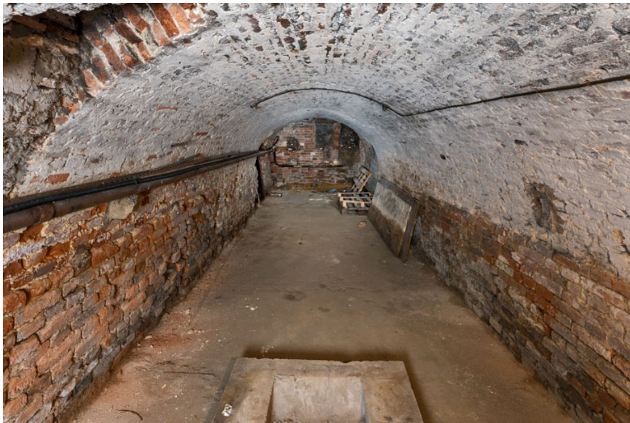
Cave voûtée au sous-sol.
