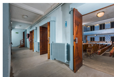
Galerie vitrée et entrée de la salle. Phot. Pierre-Marie Barbe-Richaud IVR26_20257100498NUC4A
