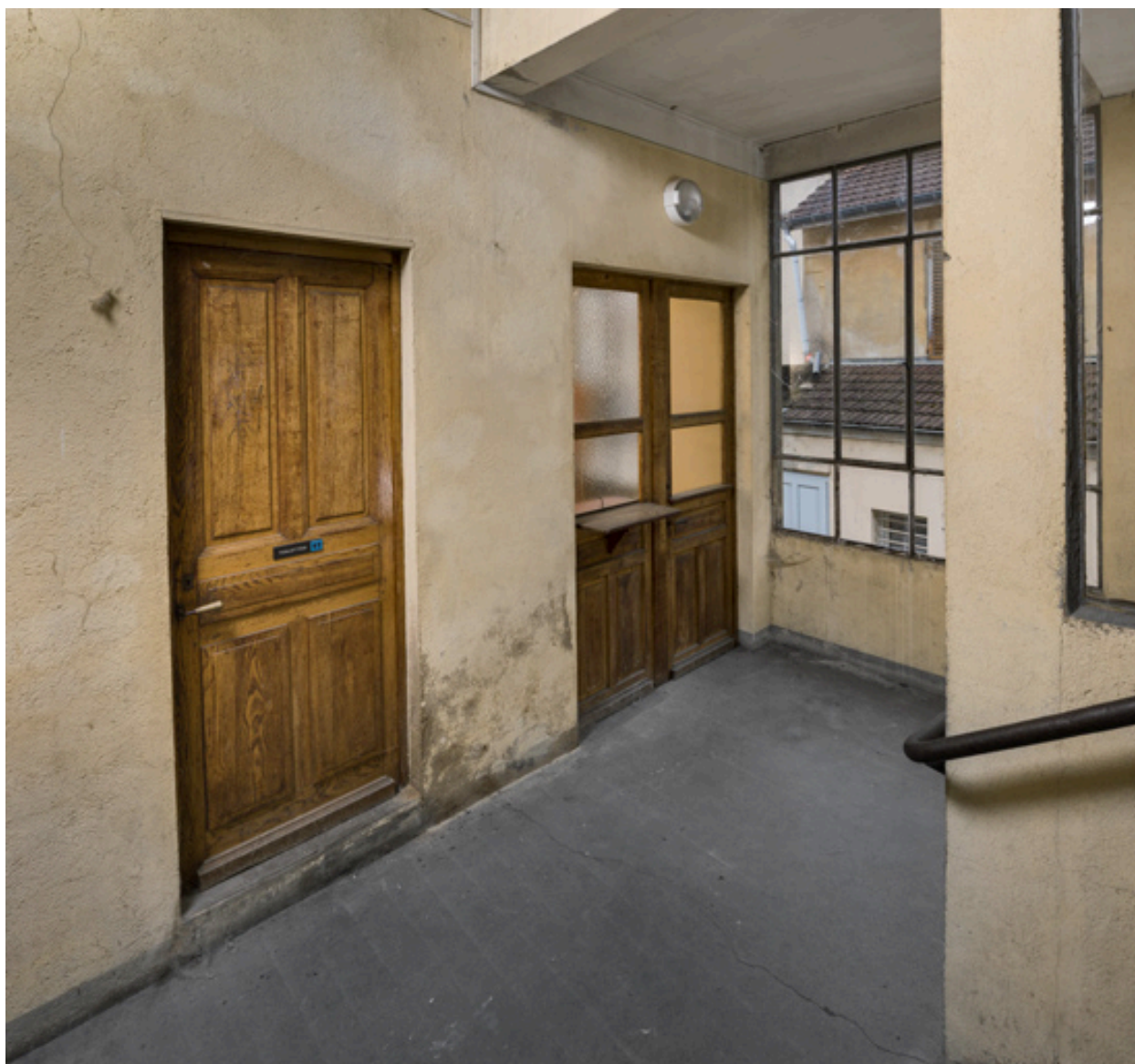
Escalier principal, repos : porte des sanitaires et guichet.
