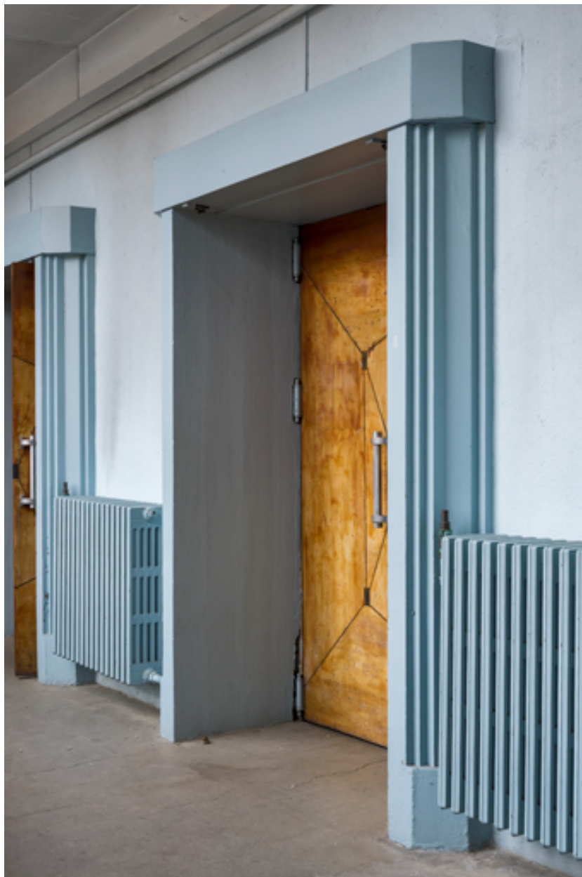
Galerie vitrée : porte de la salle, vue en enfilade.
