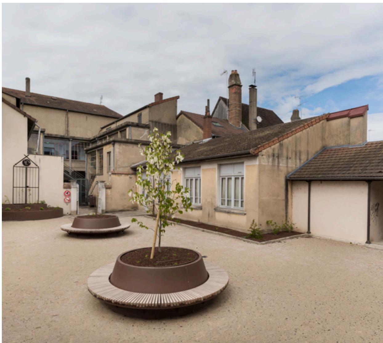
Façade postérieure et dépendances, depuis la deuxième cour au sud (vue d'ensemble).
