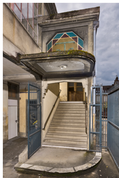
Cage de l'escalier principal. Phot. Pierre-Marie Barbe-Richaud IVR26_20257100493NUC4A
