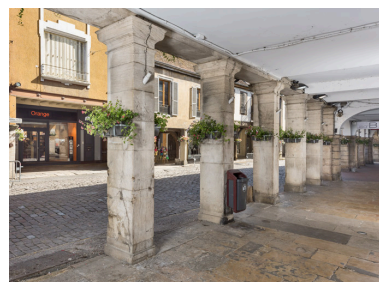
Galerie ouvrant sur la rue. Phot. Pierre-Marie Barbe-Richaud IVR26_20257100538NUC4A
