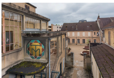
Cage de l'escalier principal (dépendance est) à gauche et loges d'acteur à droite, depuis la galerie vitrée. Phot. Pierre-Marie Barbe-Richaud IVR26_20257100487NUC4A
