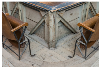
Balcon : structure métallique du garde-corps. Phot. Pierre-Marie Barbe-Richaud IVR26_20257100531NUC4A
