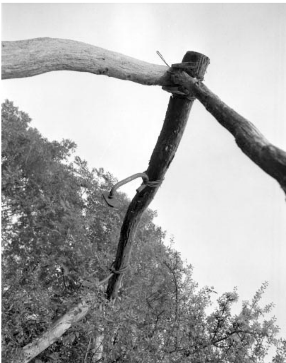
Détail des crochets retenant les câbles qui permettaient de descendre le lait jusqu'à la fromagerie.
