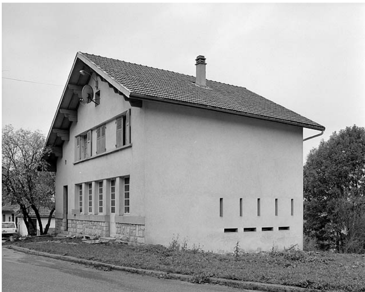
Façade antérieure et face droite.
