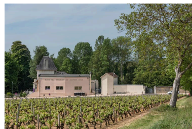
Façade latérale. Phot. Pierre-Marie Barbe-Richaud IVR26_20222100213NUC4A
