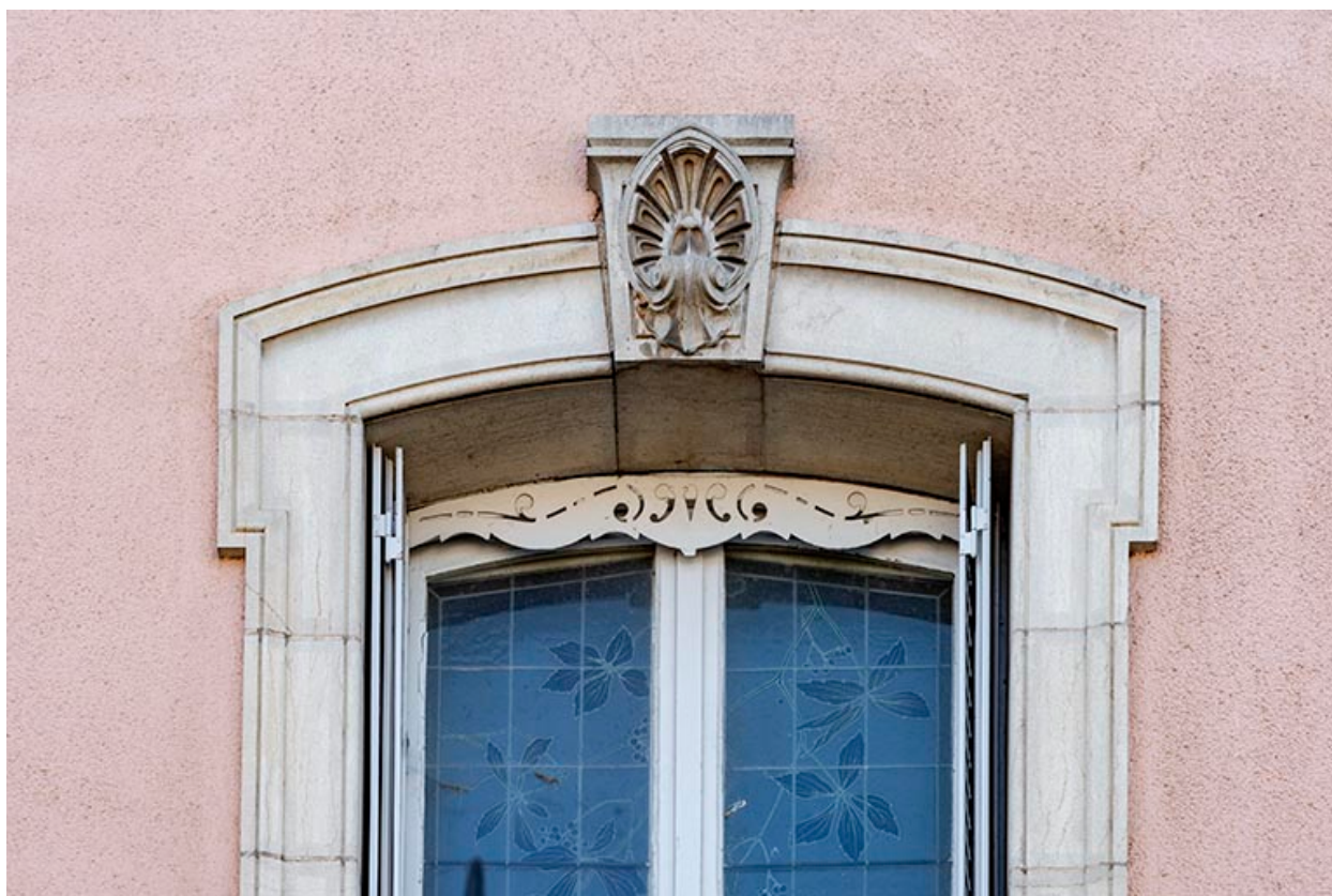
Fenêtre avec clé de voûte, façade antérieure.
