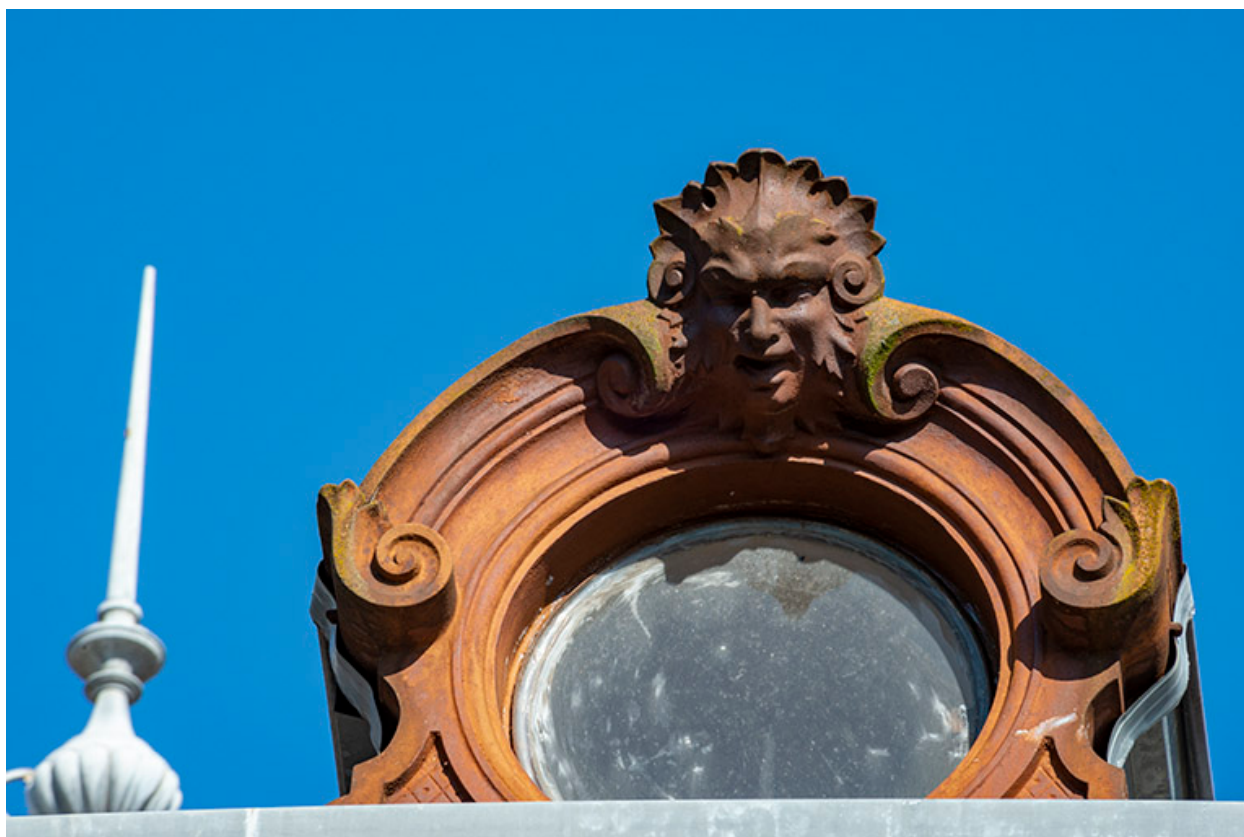
Détail de la lucarne.
