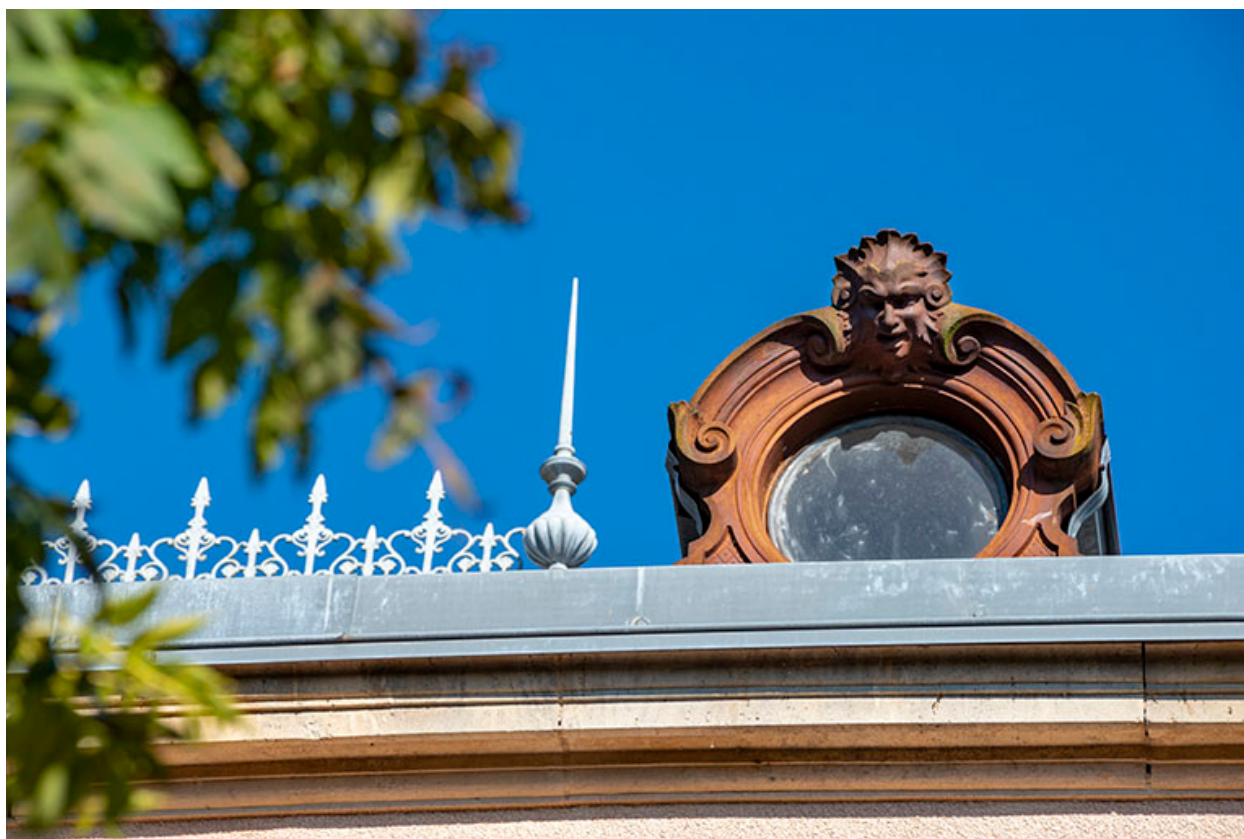
Lucarne, façade postérieure.
