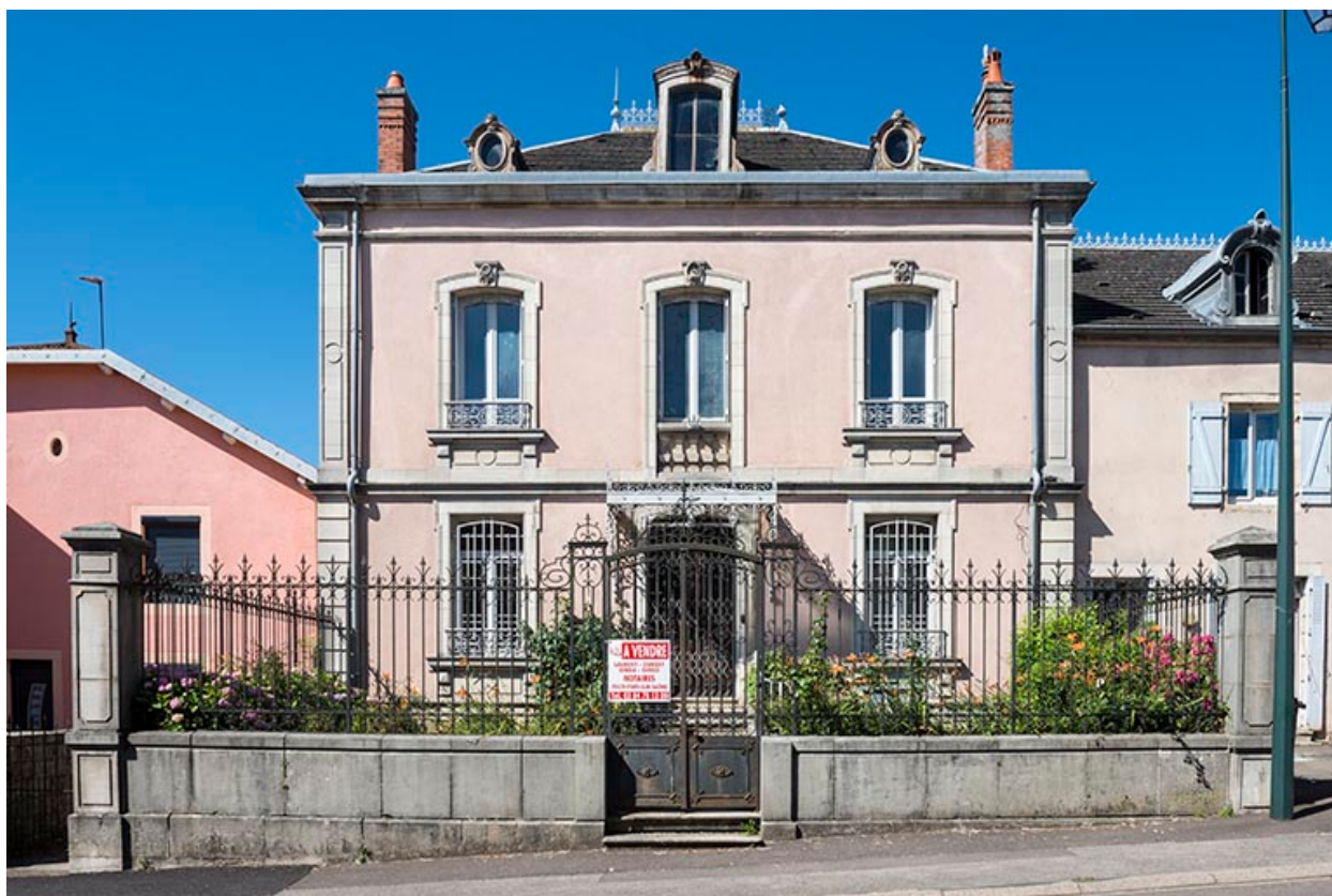
Vue d'ensemble de la façade antérieure.
