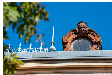
Lucarne, façade postérieure. Phot. Jérôme Mongreville IVR43_20187000740NUC4A
