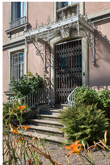
La porte d'entrée. Phot. Jérôme Mongreville IVR43_20187000382NUC4A
