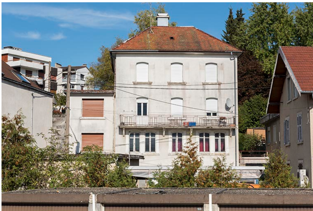
Maison : façade antérieure.
