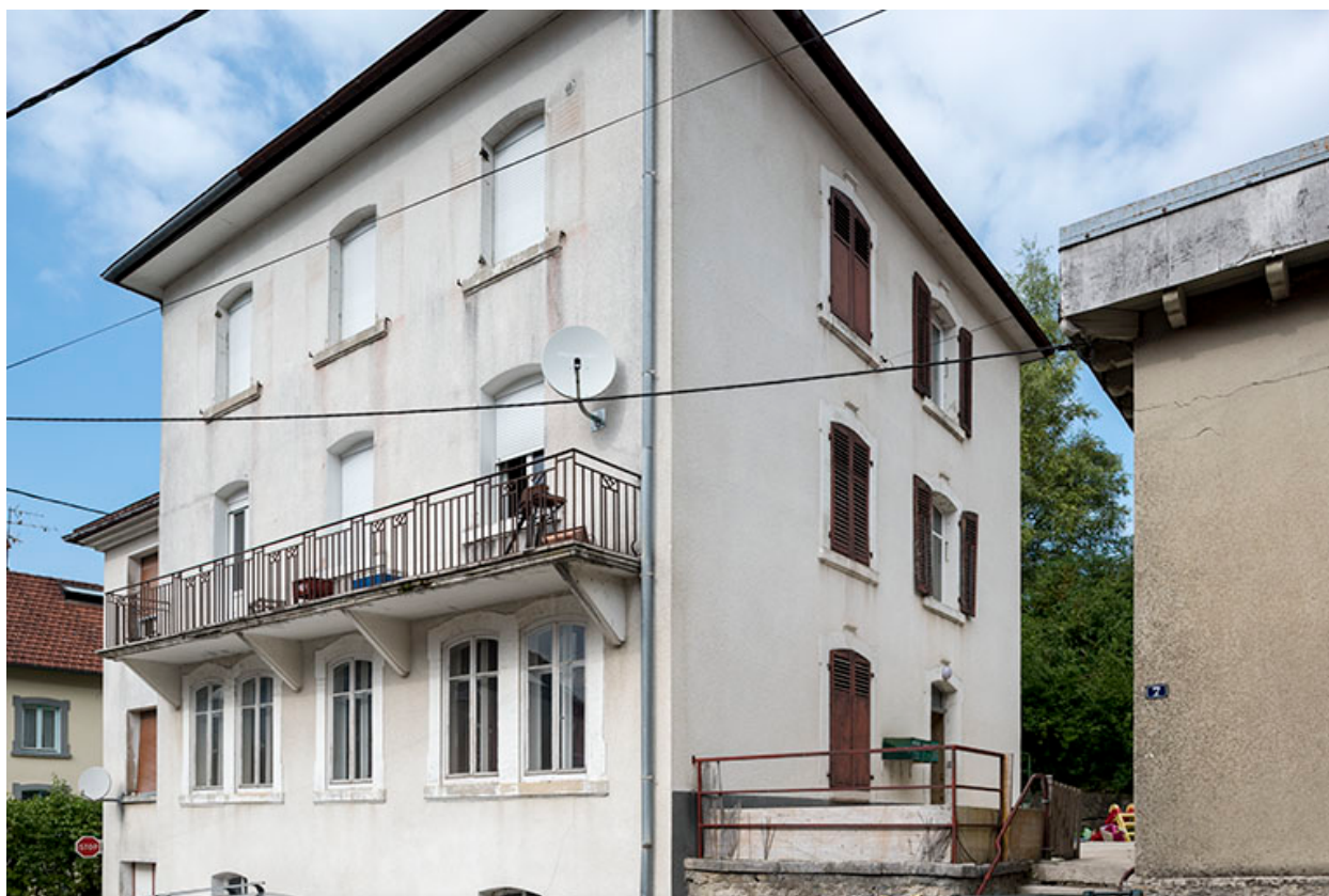
Maison : façades antérieure et latérale droite.
