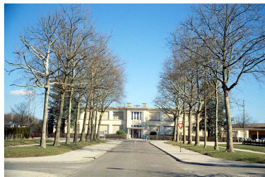
Façade antérieure, vue de situation.
